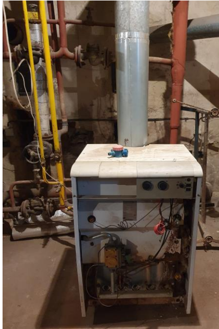
Obrázok 9.1 Štandardný stacionárny plynový kotol s jednostupňovým horákom
