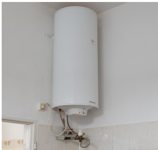
Obrázok 9.5 elektrokotol so zásobníkom TV
