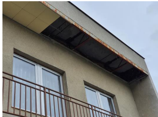
Obrázok 8.2 Zlý stav lodžiových podhládov
