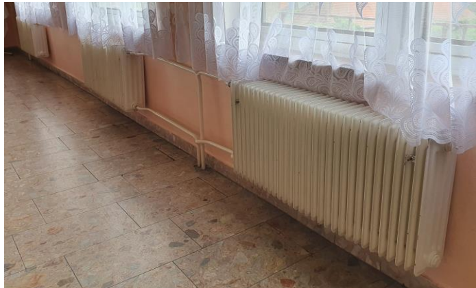
Obrázok 9.4 Článkové ocelové vykurovacie telesá
