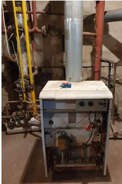
Obrázok 9.1 Štandardný stacionárny plynový kotol s jednostupňovým horákom
