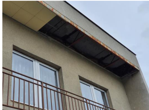
Obrázok 8.2 Zlý stav lodžiových podhládov
