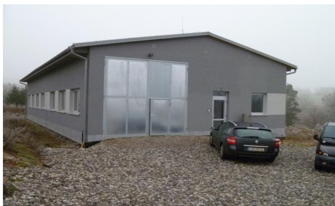
Obr. 16 Výrobní hala firmy Bližňák - Kovovýroba (čelní pohled).
