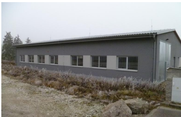
Obr. 17 Výrobní hala firmy Bližňák - Kovovýroba (boční pohled).
