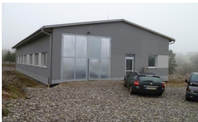
Obr. 16 Výrobní hala firmy Bližňák - Kovovýroba (čelní pohled).
