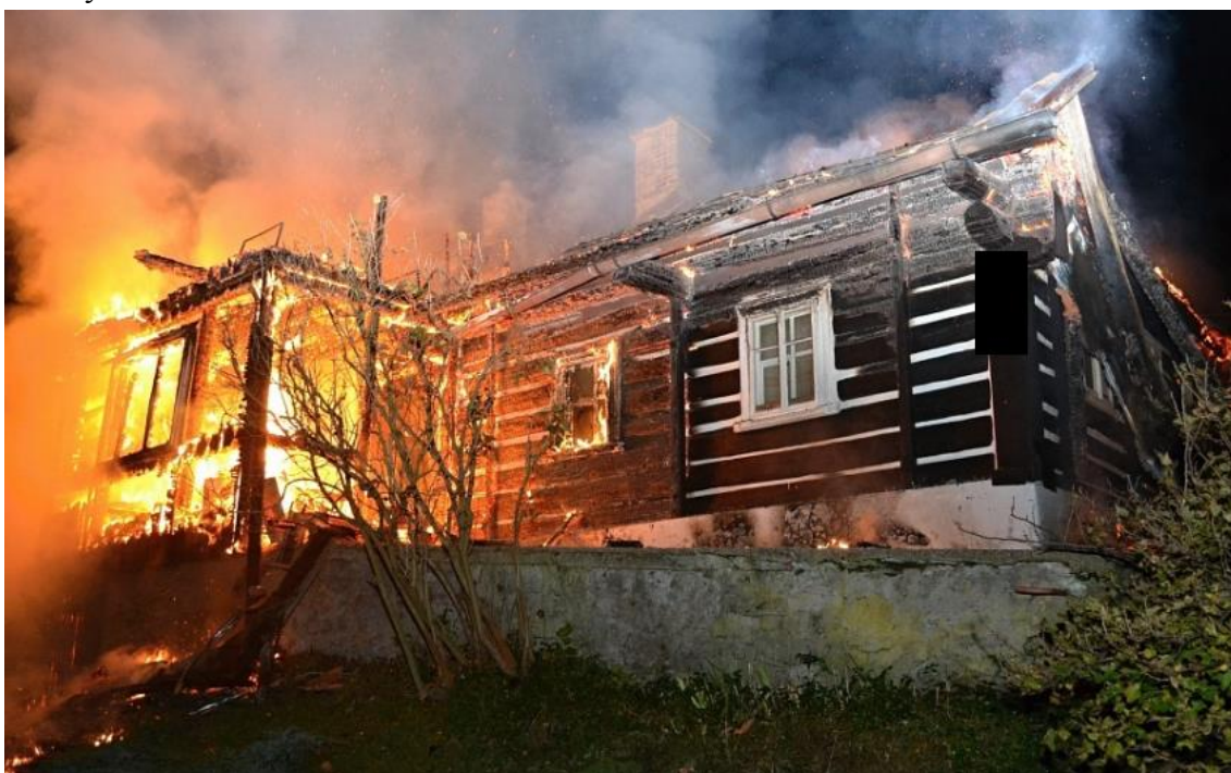
Obrázek 5-10 – Objekt během vzniku škodní události [interní materiál ČPJ]
