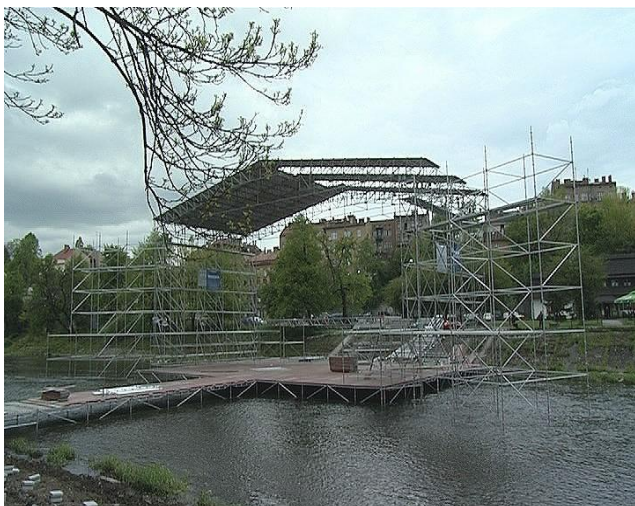
Příloha IX Samotná železná stavba na řece Olše
