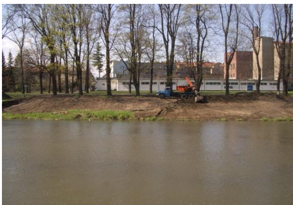
Příloha X Úprava břehu pro hlediště na české straně řeky Olše
