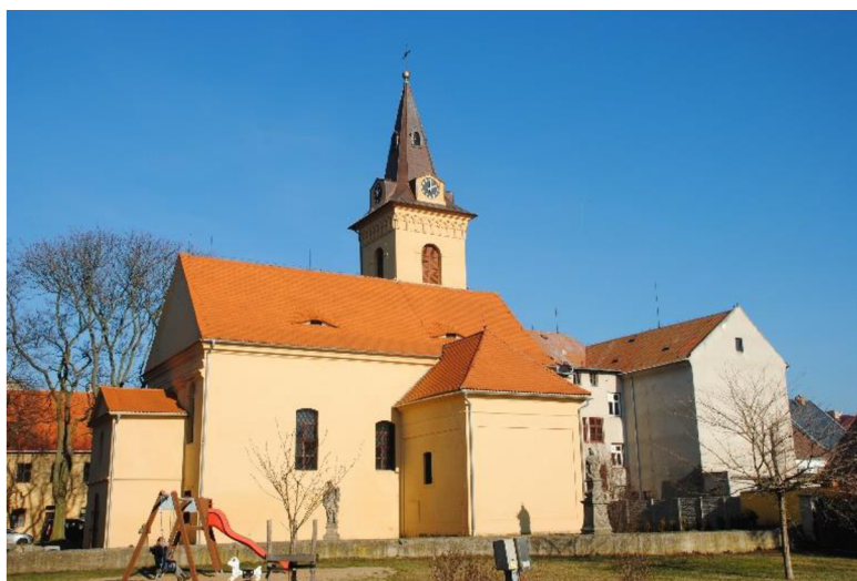
Obrázek 4: Kostel Povýšení sv. Kříže (foto: vlastní, únor 2022).
