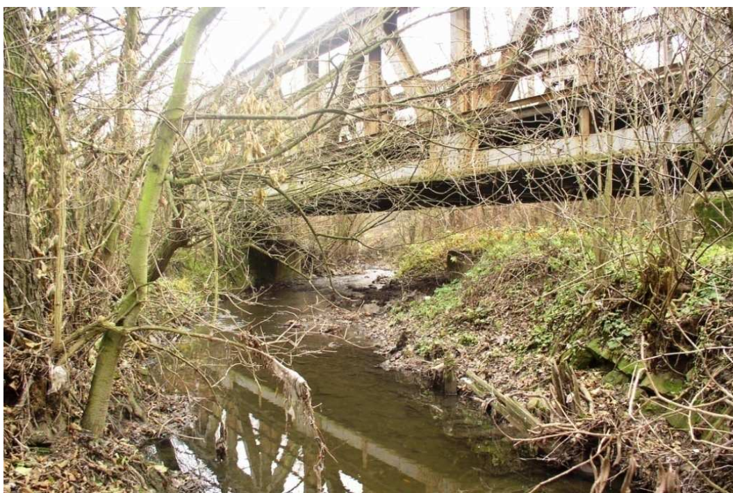
Obr. 4-4 Pohled na spodní stavbu železničního mostu
