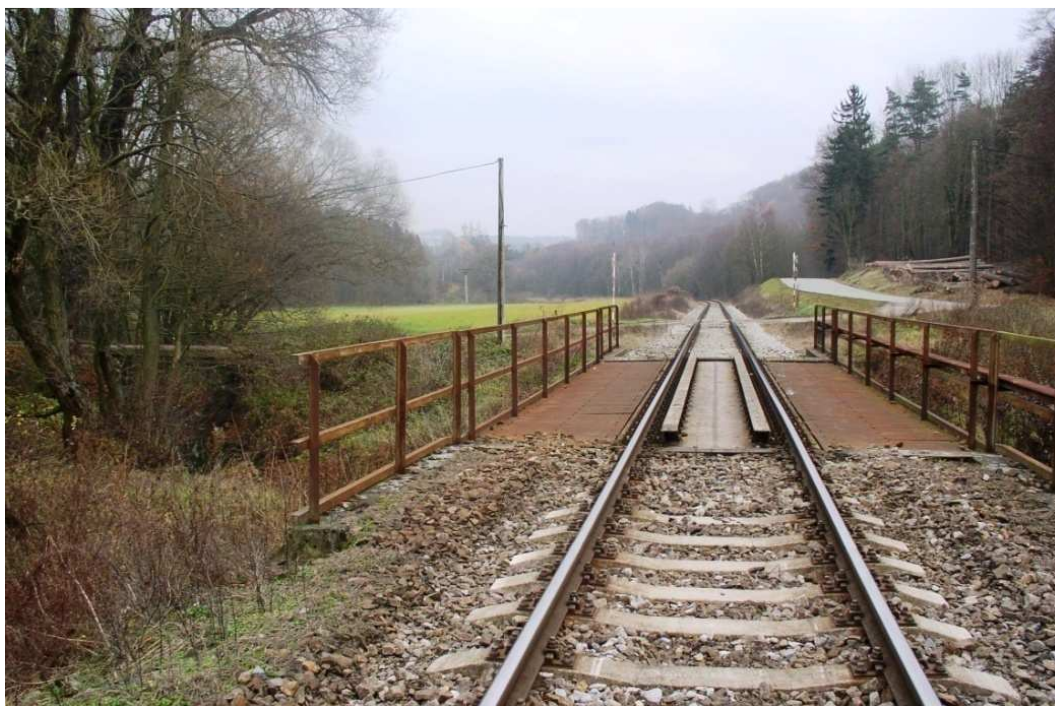
Obr. 4-5 Konstrukce železničního mostu, pohled směr Omice
