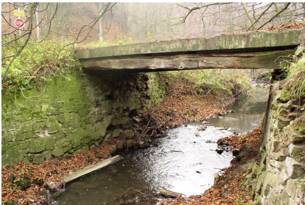
Obr. 4-7 Konstrukce silničního mostu, pohled proti proudu Bobravy
