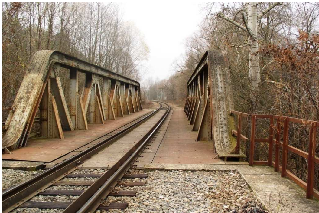
Obr. 4-3 Konstrukce železničního mostu , pohled směr Tetčice
