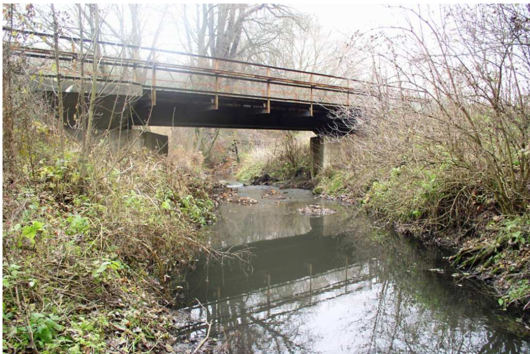
Obr. 4-6 Konstrukce železničního mostu, pohled po proudu Bobravy
