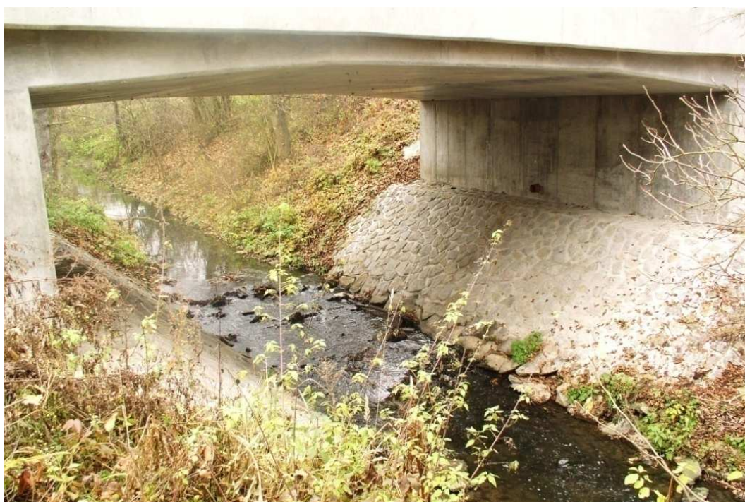
Obr. 4-9 Konstrukce silničního mostu, pohled na spodní stavbu mostu
