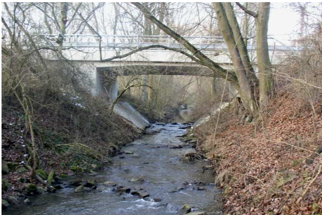
Obr. 4-10 Konstrukce silničního mostu, pohled proti proudu toku
