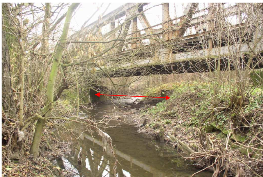
Obr. 10-3 Pohled na spodní část mostu, konstrukce které byly odstraněny
