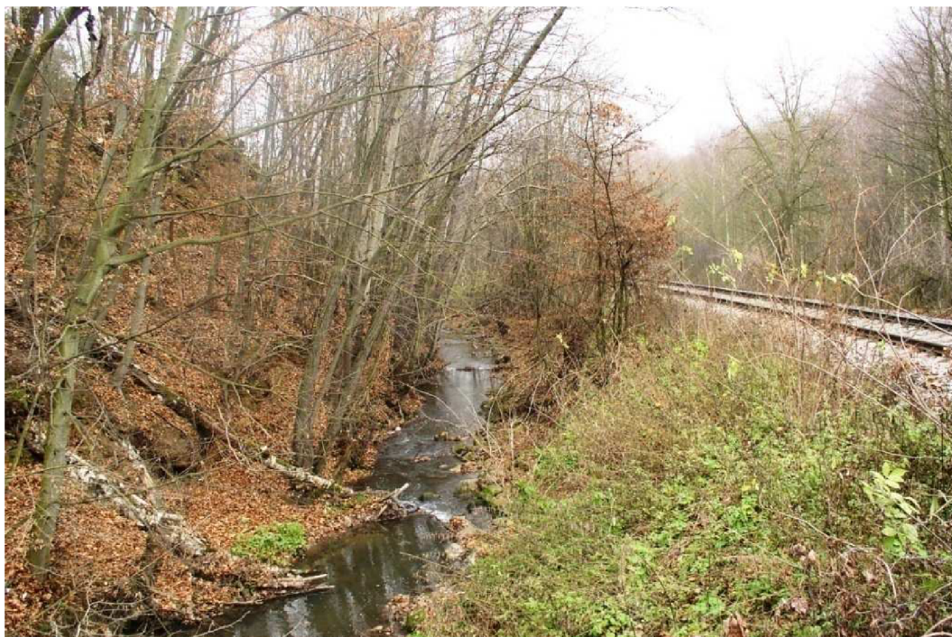
Obr. 4-2 Pohled na zemní těleso železnice, pohled u Bažantnice
