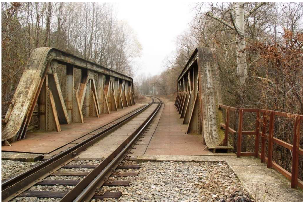
Obr. 4-3 Konstrukce železničního mostu , pohled směr Tetčice
