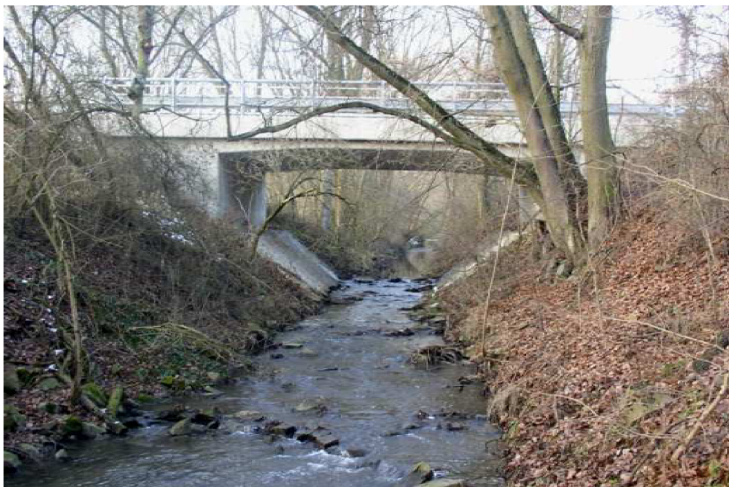
Obr. 4-10 Konstrukce silničního mostu, pohled proti proudu toku
