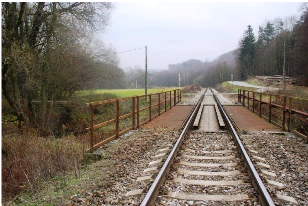
Obr. 4-5 Konstrukce železničního mostu, pohled směr Omice
