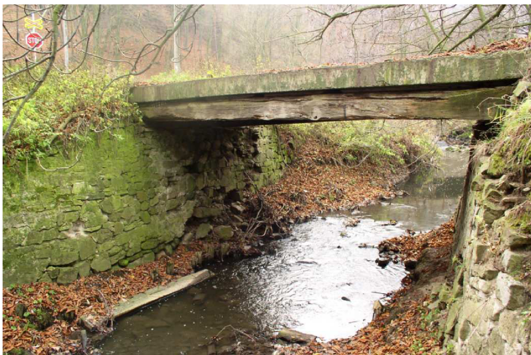
Obr. 4-7 Konstrukce silničního mostu, pohled proti proudu Bobravy
