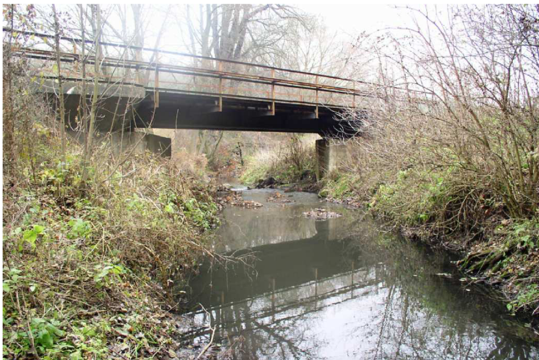
Obr. 4-6 Konstrukce železničního mostu, pohled po proudu Bobravy
