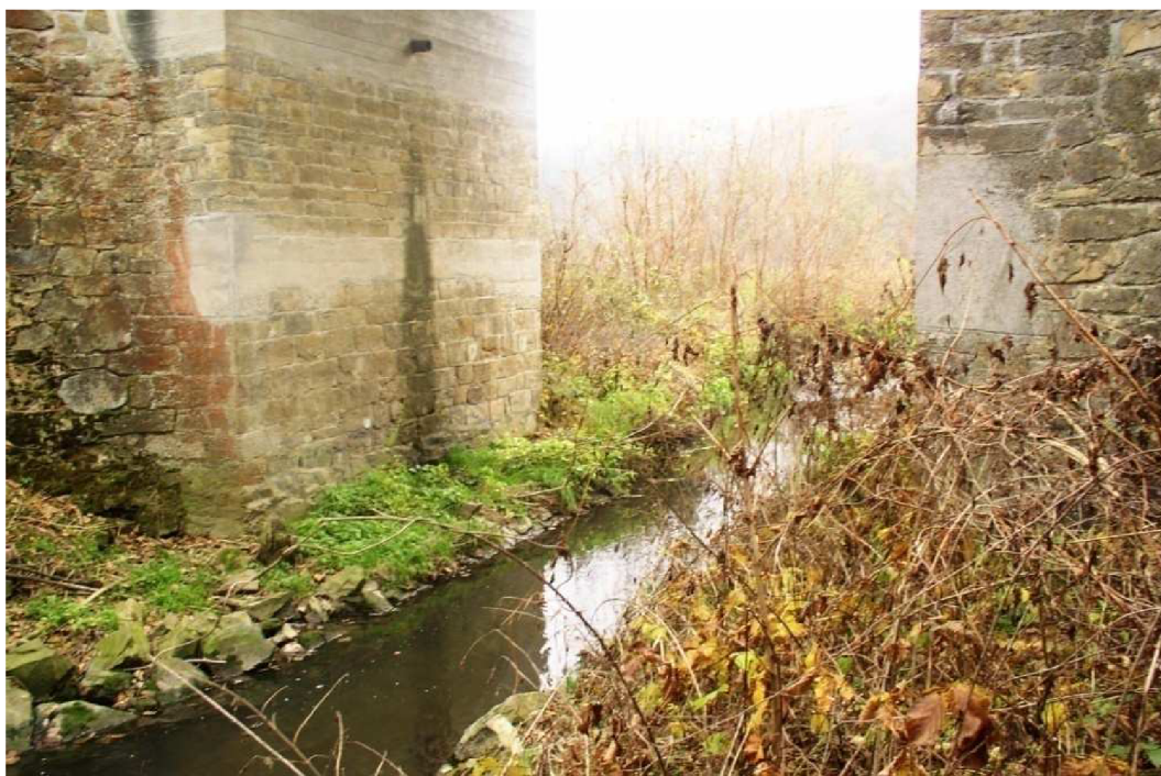
Obr. 4-11 Konstrukce železničního mostu, pohled na spodní stavbu mostu
