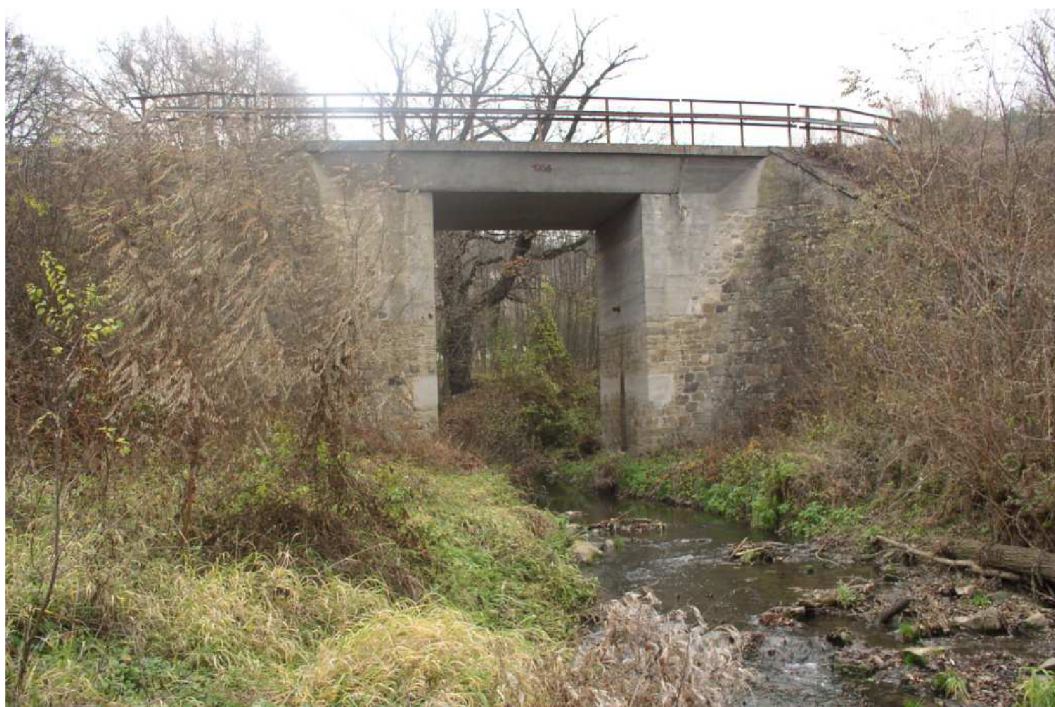
Obr. 4-12 Konstrukce železničního mostu, celkový pohled na mostní konstrukci
