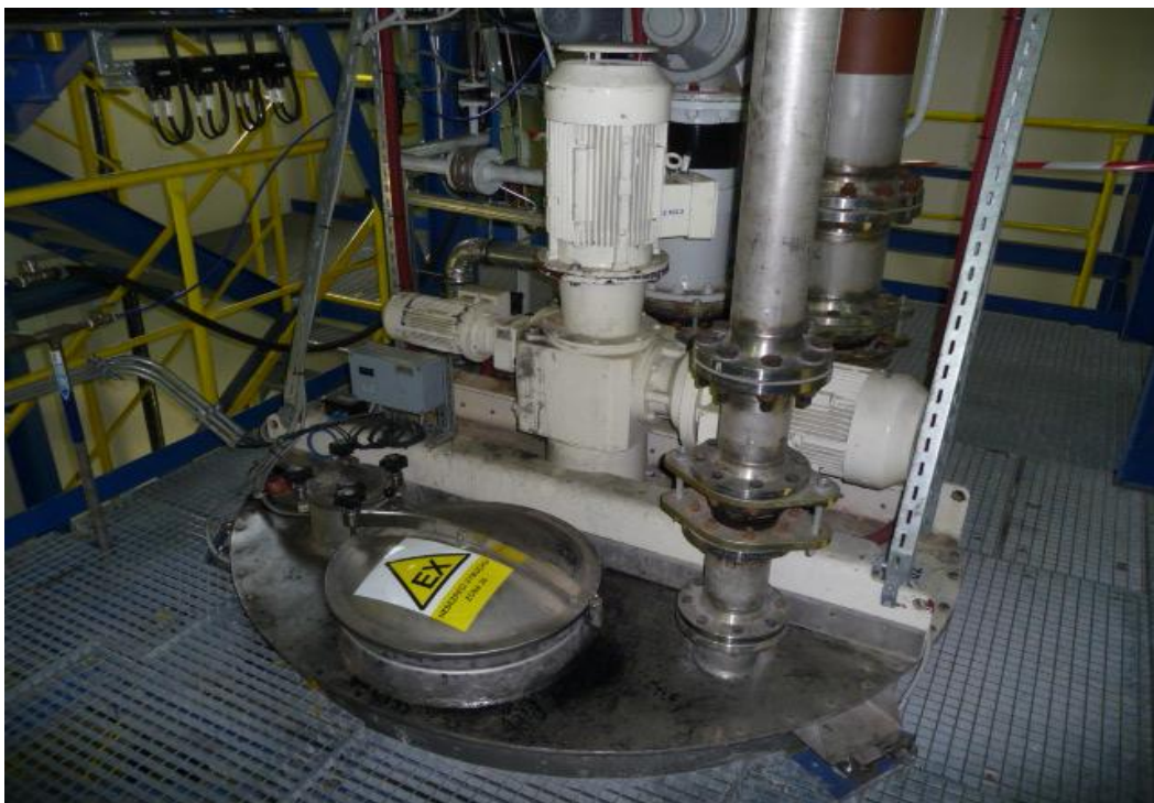
Obrázek 9 – Homogenizér/mixér Z 102 na T 700 Unipetrol RPA s.r.o.
