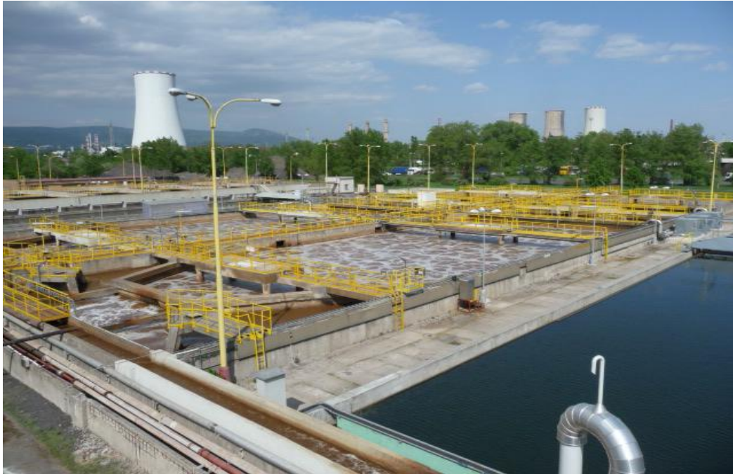
Obrázek 3 – Aktivační nádrž AN II, dosazovací nádrž DN II, BČ Unipetrol RPA s.r.o.
