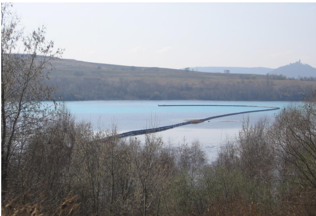
Obrázek 13 – Nová popelová skládka Kopisty s viditelným plovoucím potrubím na hladině laguny Unipetrol RPA s.r.o.
