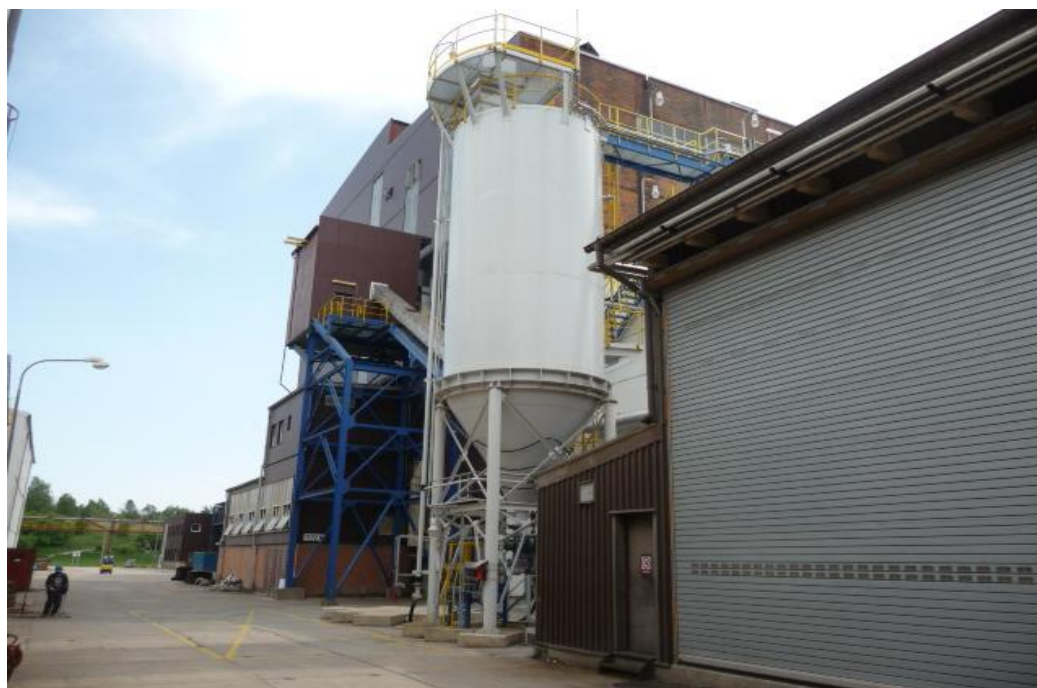
Obrázek 7 – Silo chezakarbu H 103 na T 700 Unipetrol RPA s.r.o.
