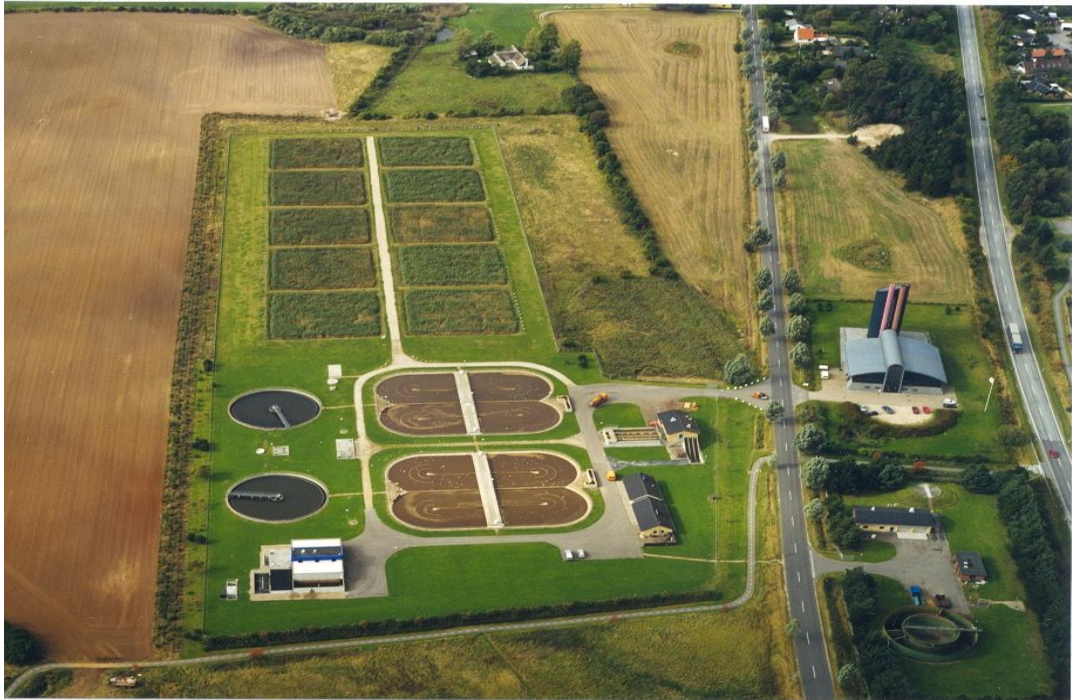
Obrázek 2 - Stabilizace kalů na ČOV Helsingør v Dánsku pro 42 000 EO. Deset rákosových polí (na obrázku za aktivační čistírnou) zpracovává ročně 650 tun aktivovaného kalu od roku 1996. Foto Steen Nielsen.
