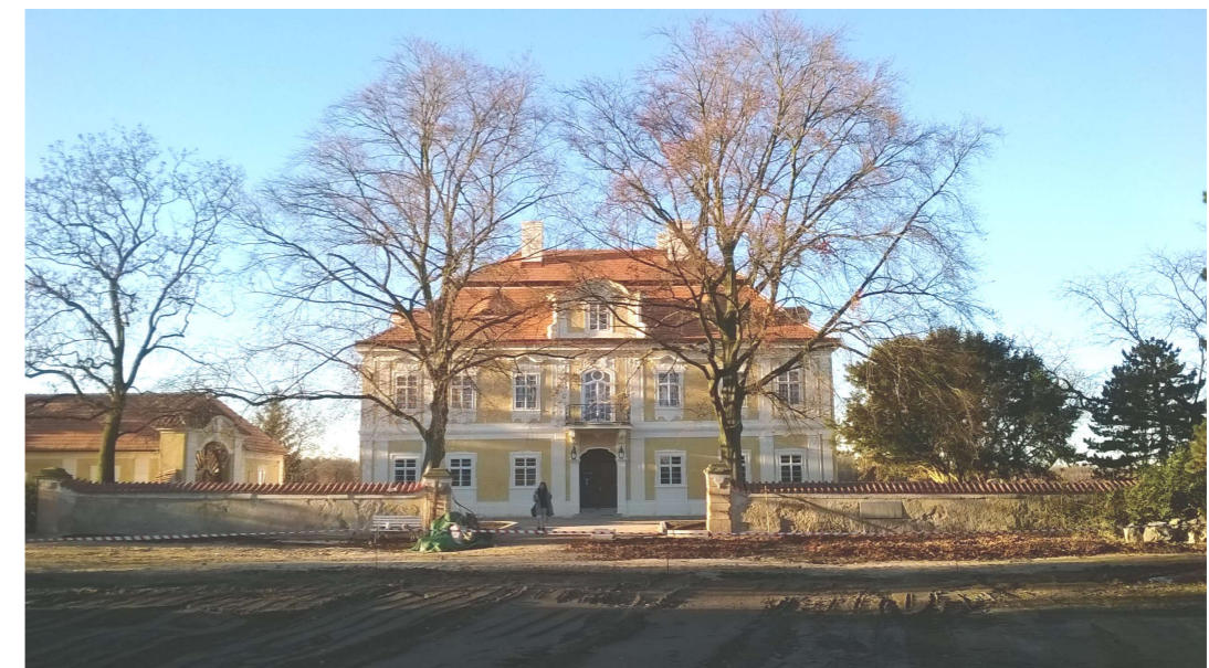
Obr. 9: Ústřední pohled na zrekonstruovaný zámek a rozrušený hlavní parter od těžké techniky. (Foto: vlastní, prosinec 2016)
