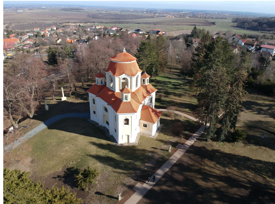
Obr. 61: Jiho- východní pohled na kapli sv. Anny a lipovou alej. (Zdroj: Foto vlastní)
