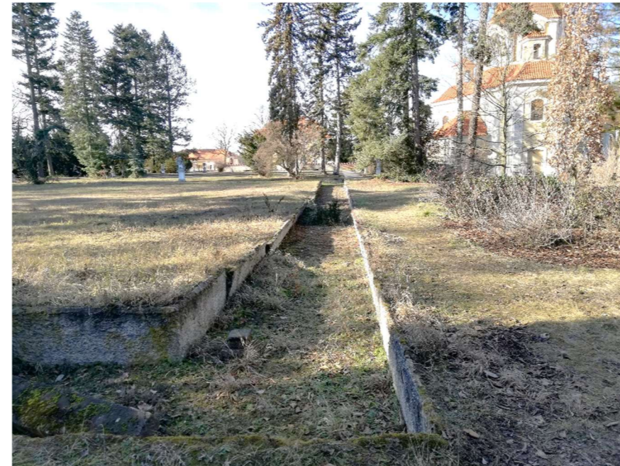
Obr. 41; 42: Parku dominují dvě významné vodní stavby a to pravidelný bazén z období první republiky s altány a pergolou situovaný v JV části parku. Druhým je pravidelný vodní kanál na zadní centrální ploše před zámkem. Jejich vodní okruh je vzájemně propojen a čerpá vodu ze zámecké studny pomocí tlakového čerpadla. Voda v kanále byla naposledy pamatována v polovině 20. století. V současné době probíhá výběrové řízení na obnovu těchto významných prvků, které přinesou do parku oživení. (Zdroj: Foto vlastní)
