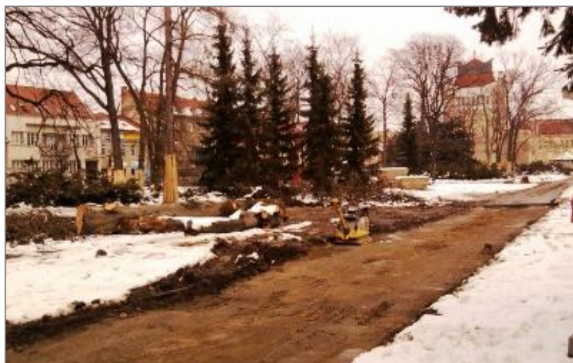
Obr. 16 Přestavba Smetanových sadů (foto: B. Kalábová, 2.4 2013)
