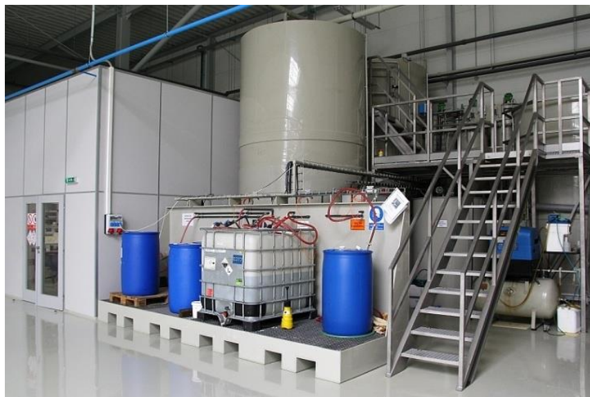
Obrázok 2: Neutralizačná stanice firmy Gatema a.s. s kapacitou 75 m 3 /deň [7]
