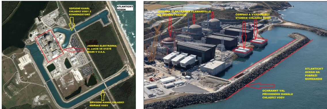
Obr. 2.6 Elektrárny St. Lucie a Flamanville chlazené pomocí mořské vody [7] [8]
