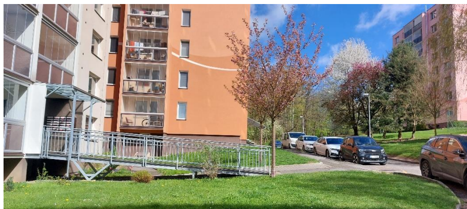
Obrázek 22. Rampa ke hlavnímu vstupu (Zdroj: archiv autora)
