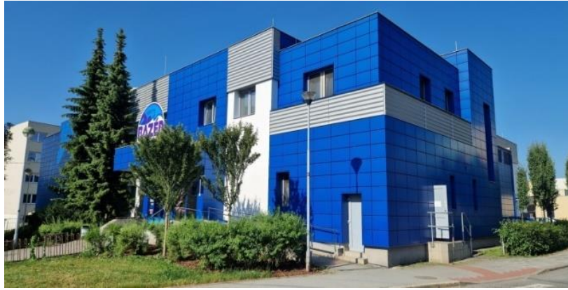
Obrázek 25. Krytý bazén (Zdroj: archiv autora)
