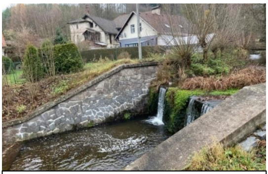
Objekt č. 5 , staničení 3.162 ř. km, foceno proti proudu
