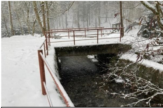
Objekt č. 9 , staničení 3.758 ř. km, foceno po proudu
