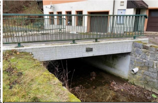
Objekt č. 10 , staničení 4.840 ř. km, foceno po proudu
