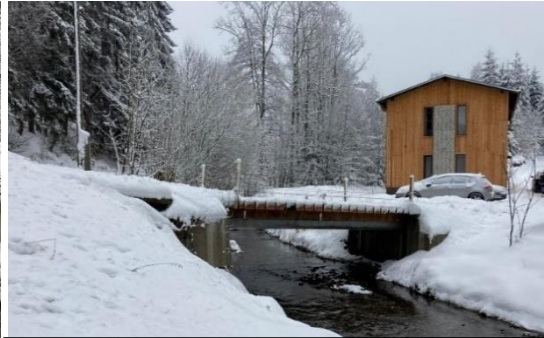
Objekt č. 18 , staničení 8.236 ř. km, foceno proti proudu
