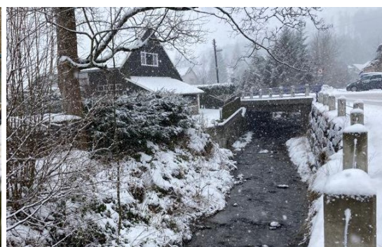
Objekt č. 4 , staničení 3.036 ř. km, foceno proti proudu
