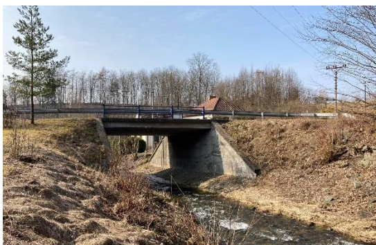
Objekt č. 1 , staničení 0.050 ř. km, foceno po proudu
