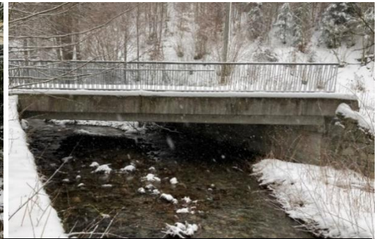
Objekt č. 12 , staničení 5.166 ř. km, foceno po proudu
