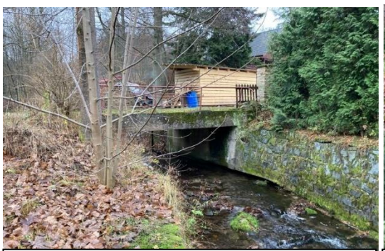
Objekt č. 7 , staničení 3.513 ř. km, foceno proti proudu
