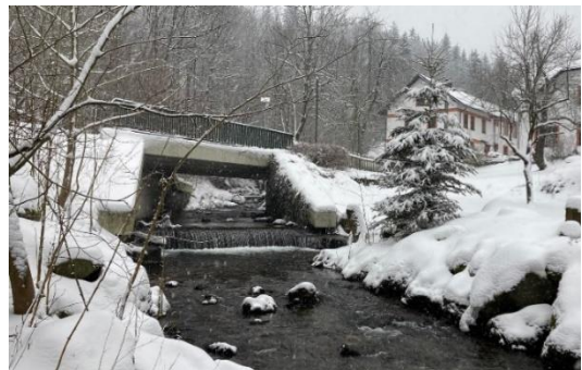
Objekt č. 13 , staničení 5.791 ř. km, foceno proti
