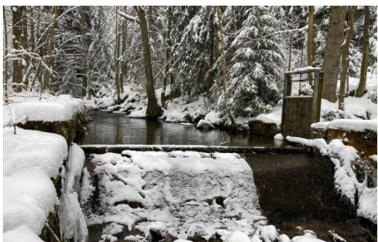
Objekt č. 15 , staničení 6.505 ř. km, foceno proti
