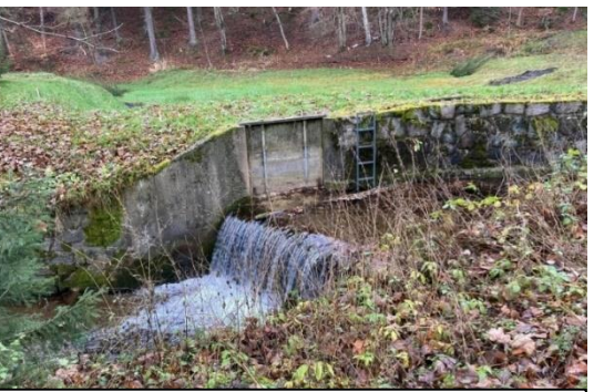
Objekt č. 8 , staničení 3.739 ř. km, foceno proti proudu
