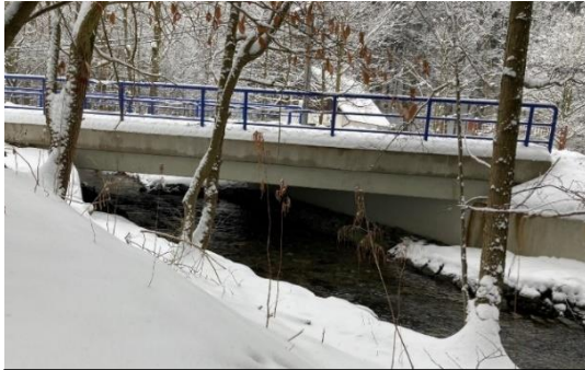
Objekt č. 17 , staničení 7.684 ř. km, foceno proti
