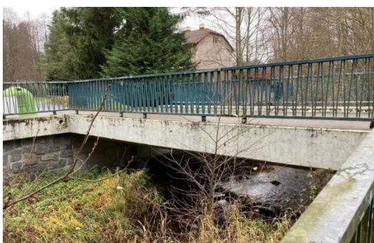
Objekt č. 3 , staničení 2.677 ř. km, foceno proti proudu
