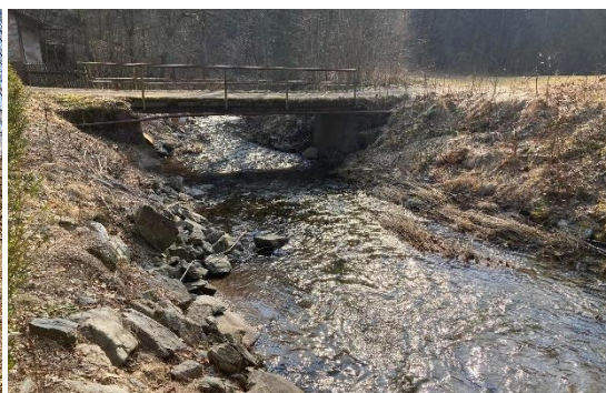
Objekt č. 2 , staničení 0.431 ř. km, foceno po proudu
