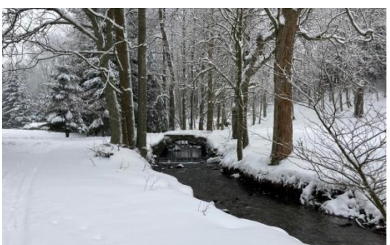
Objekt č. 16 , staničení 7.134 ř. km, foceno proti
