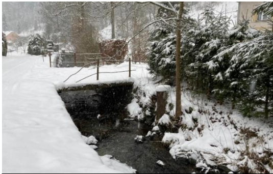
Objekt č. 11 , staničení 5.051 ř. km, foceno po proudu
