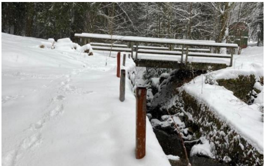
Objekt č. 14 , staničení 6.349 ř. km, foceno po proudu
