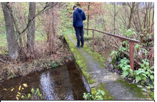
Objekt č. 6 , staničení 3.183 ř. km, foceno po proudu
