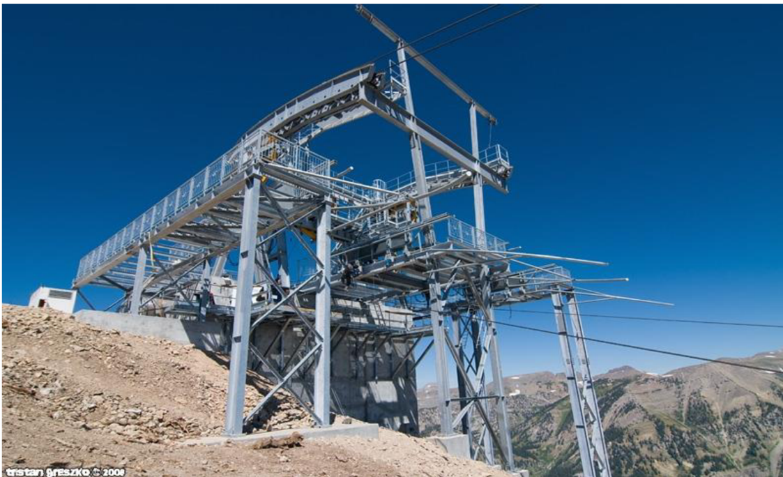
Příloha 4: Ocelová konstrukce lanovky
