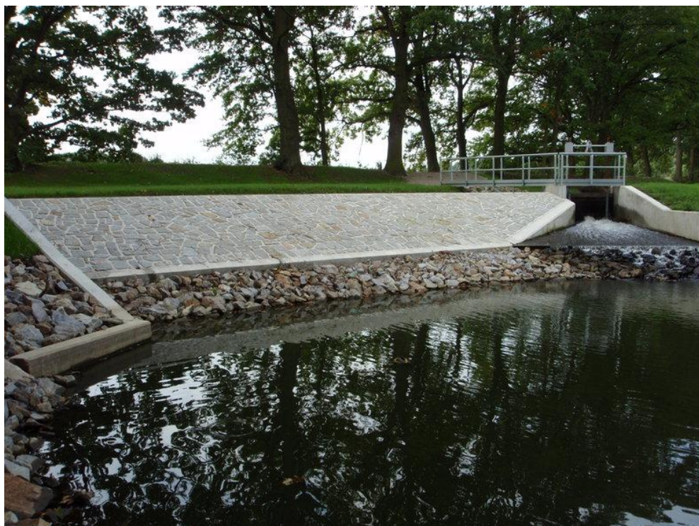
foto č. 6 – stav po realizaci
