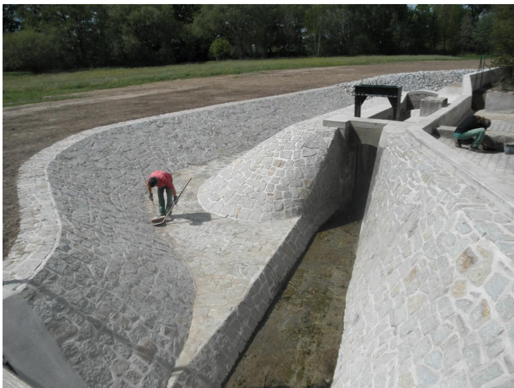
foto č. 3 – stav po realizaci
