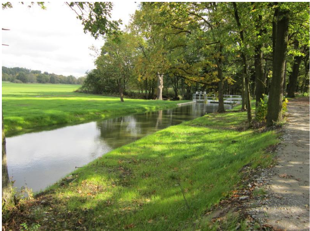
foto č. 5 – stav při realizaci
