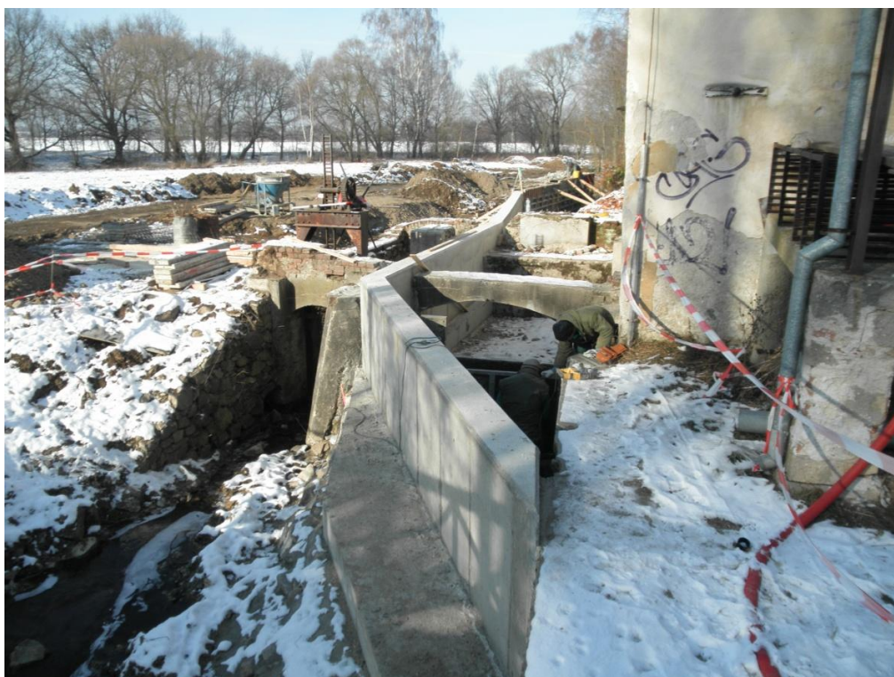
foto č. 2 – stav při realizaci
