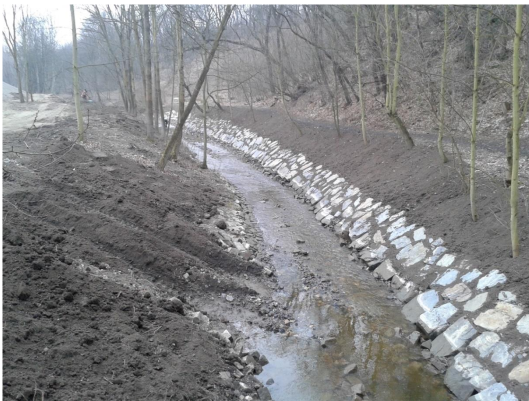
Příloha 4 – Nové opevnění pravého břehu Rokytky pod Hořejším rybníkem (zdroj: autor práce)
