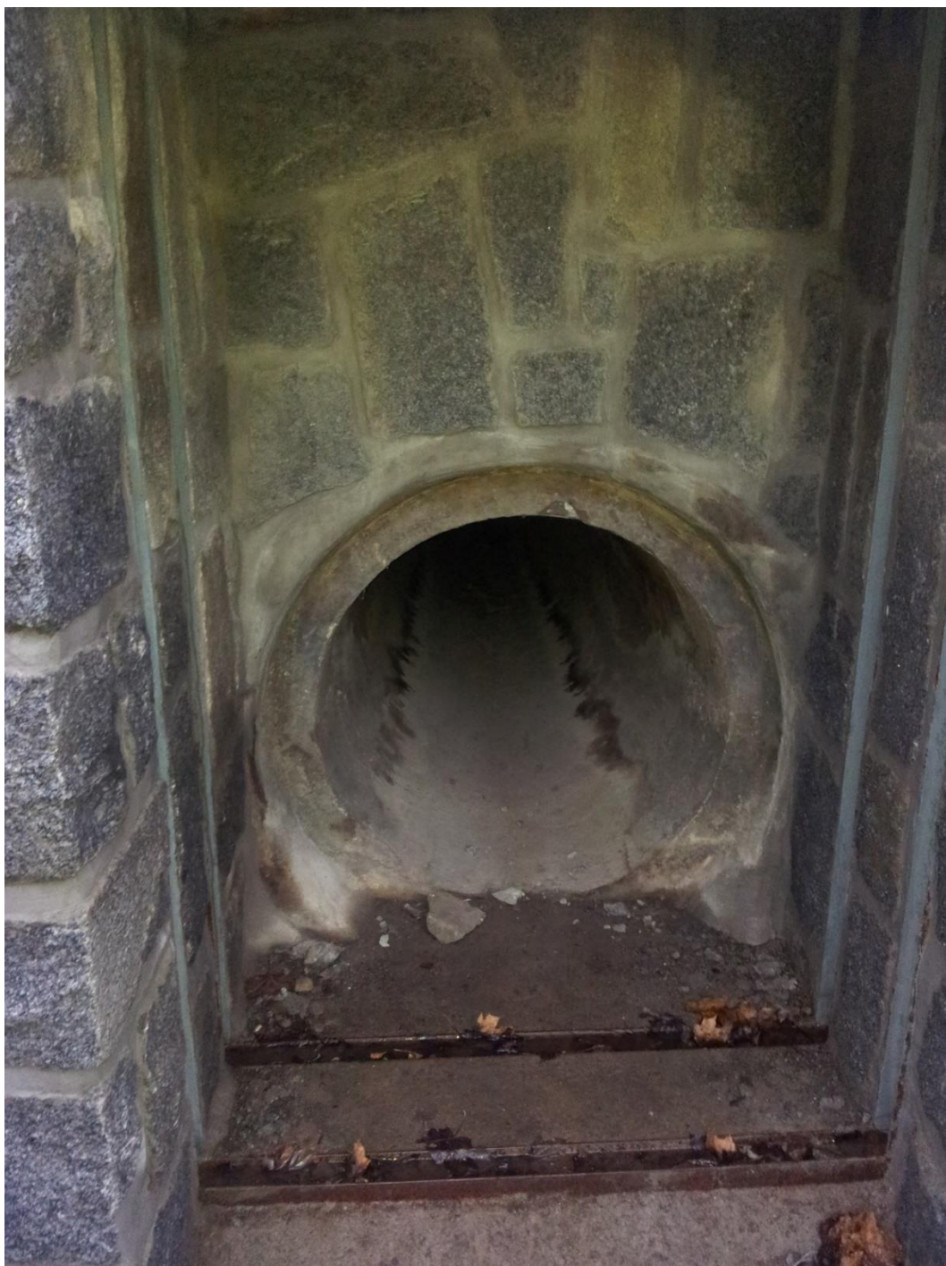
Příloha 9 – Opravený odtok do náhonu (zdroj: autor práce)
