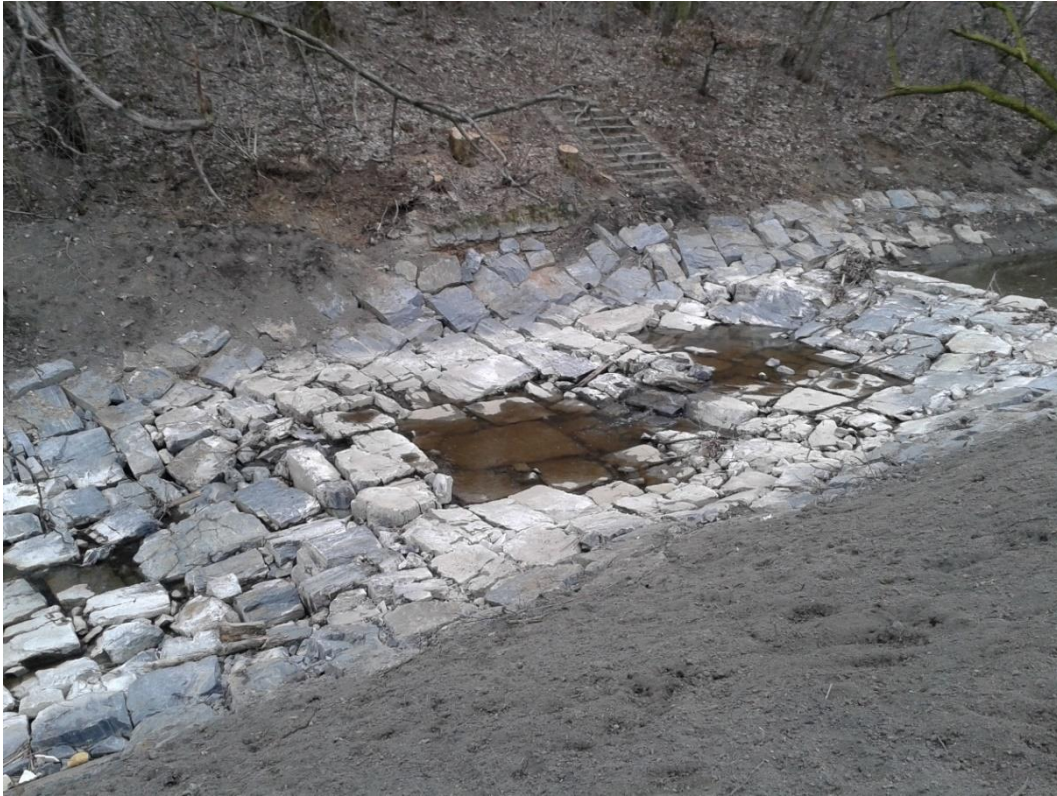
Příloha 5 – Nový skluz na Rokytce v místech bývalého sklopného jezu (zdroj: autor práce)
