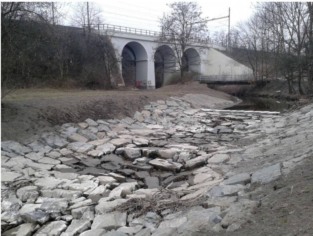
Příloha 6 – Nový skluz na Rokytce u nátokového objektu do Hořejšího rybníka (zdroj: autor práce)
