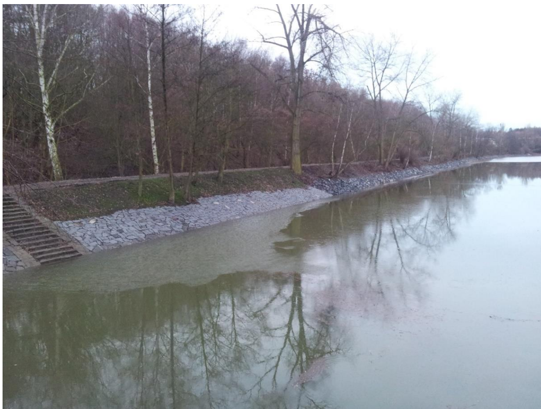
Příloha 7 – Stav břehu Hořejšího rybníka po úpravě (zdroj: autor práce)
