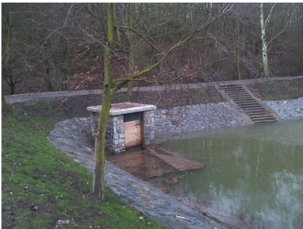
Příloha 8 – Opravený výpustný objekt (požerák) (zdroj: autor práce)
