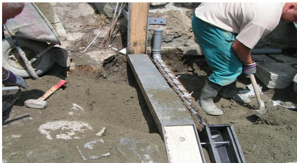
Obrázek č. 8. Stavba hlásného profilu „A“ v Netolicích. Technické provedení. Zdroj: Vlastní výzkum.
