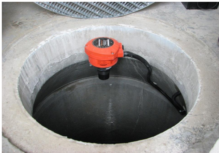
Obrázek č. 9. Hladinoměr (typ limnigrafu) umístěný uvnitř zděné stavby nad vodočetnou latí. Zdroj: Vlastní výzkum.
