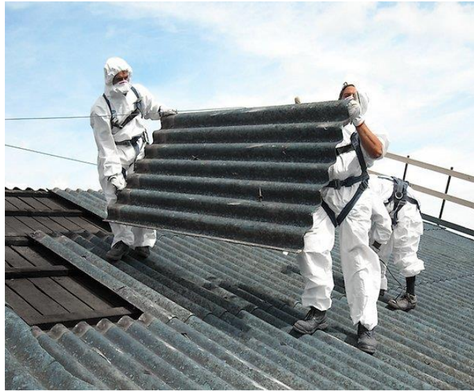
Obrázek 10 - Likvidace azbestové krytiny
