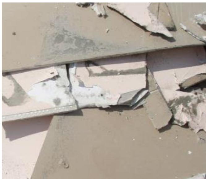
Obrázek 11 - Demoliční odpad ze sádkartonu
