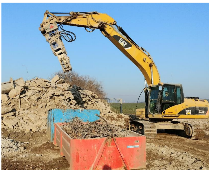
Obrázek 16 - Rozrušování materiálu pomocí vydrčovací kleště
