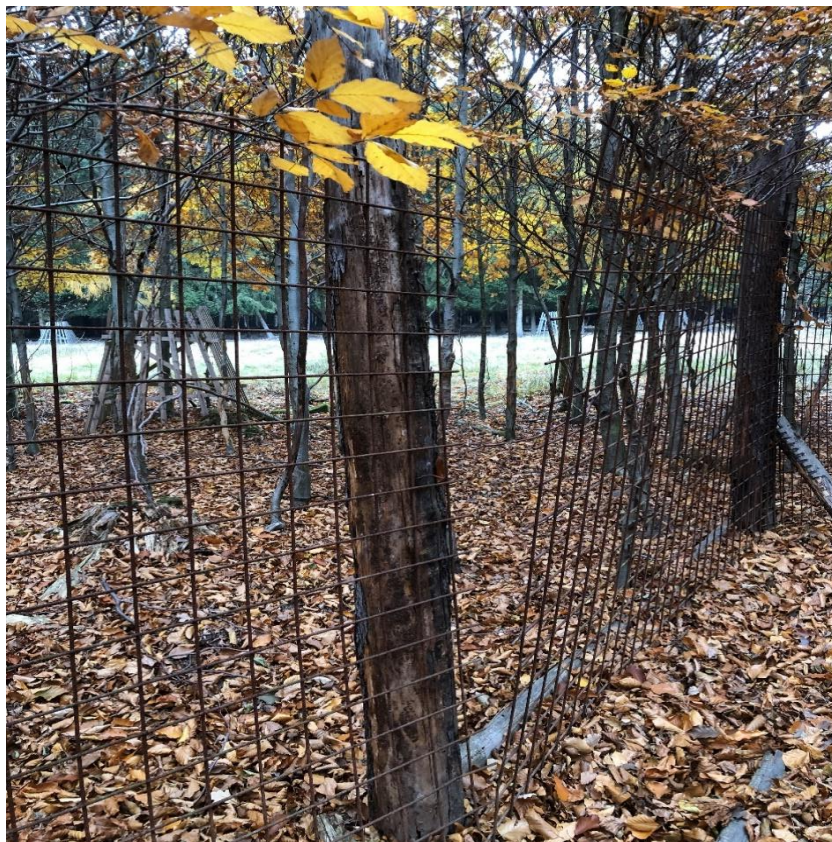
Obr. č. 29: Oborní plot s rozpojeným plotovým dílem Zdroj: vlastní zpracování
