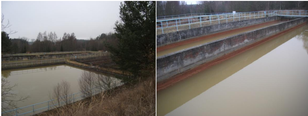
Obrázek 22 Soustava bazénů na přečerpání důlních vod (vlastní fotodokumentace)
