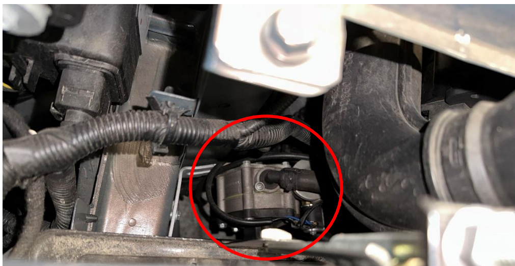
Obrázek 4.6 - Směšovač nacházející se v motorovém prostoru před demontáží
