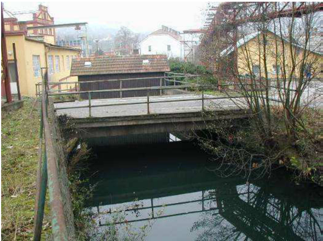
Obr.12 - Betonový most v areálu Tylex Svitava po proudu [21]
