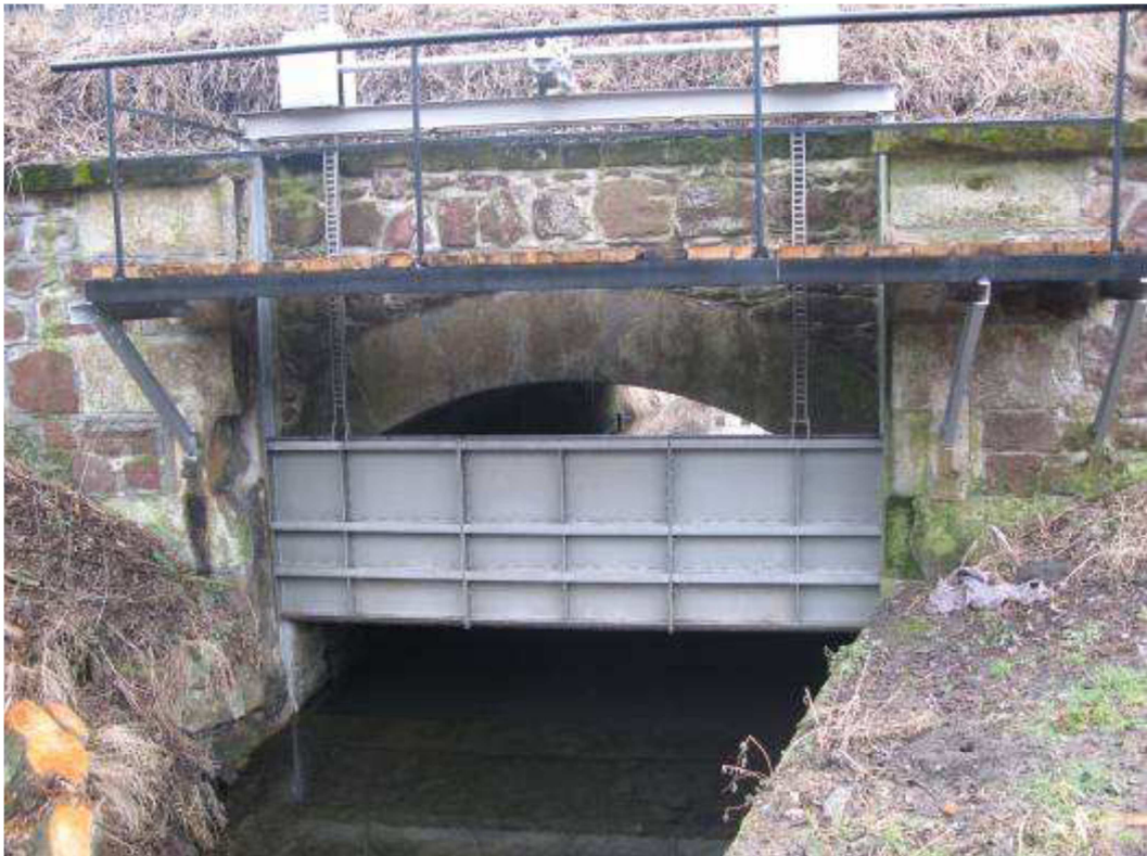
Obr.20 - Stavidlo v drážním tělese [21]
