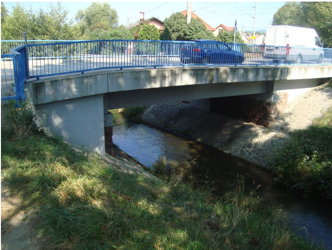
Obr.18 - Silniční most Křetínka proti toku
