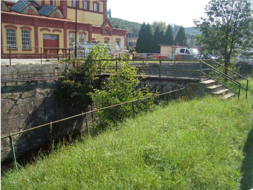
Obr.11 - Ocelová lávka Svitava po proudu
