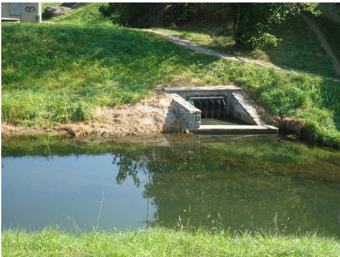
Obr.25 - Zaústění odlehčovací komory km 61.216
