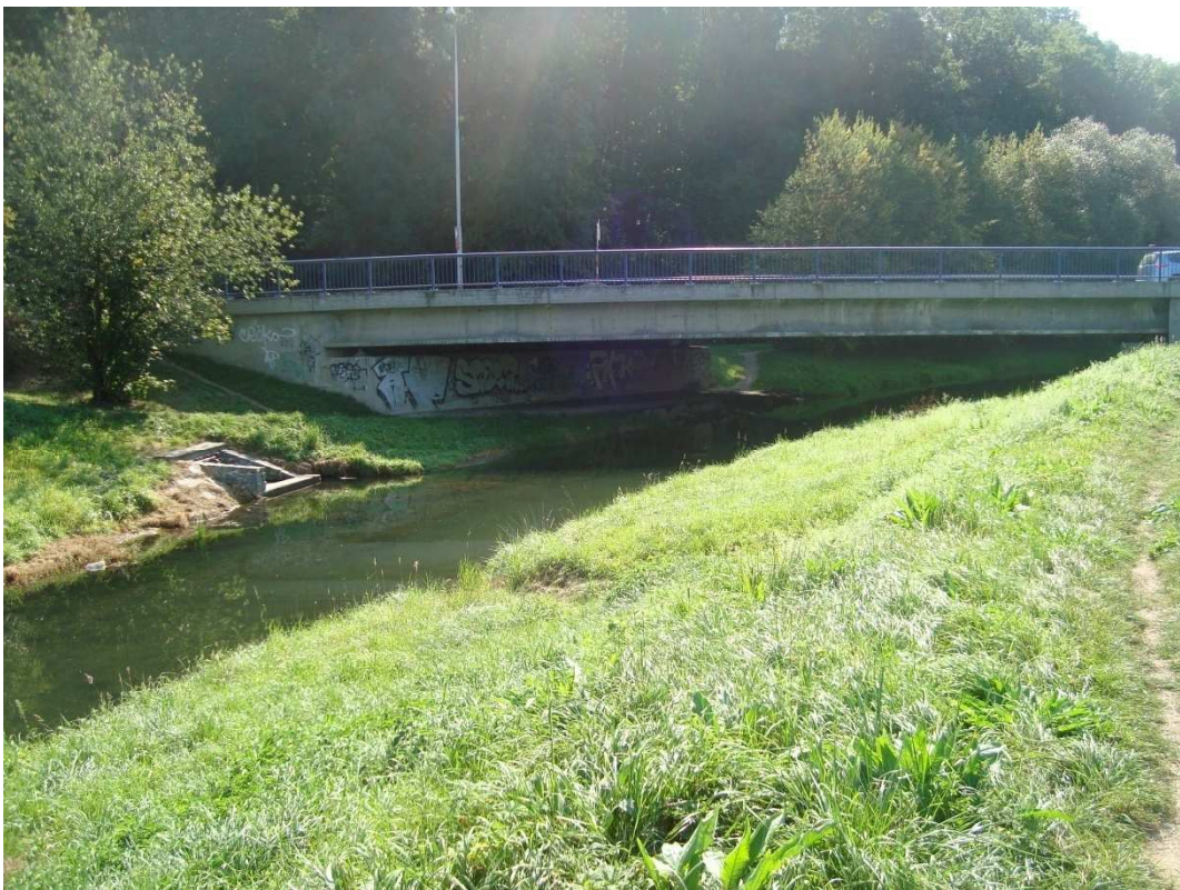
Obr.14 - Silniční most Svitava po proudu
