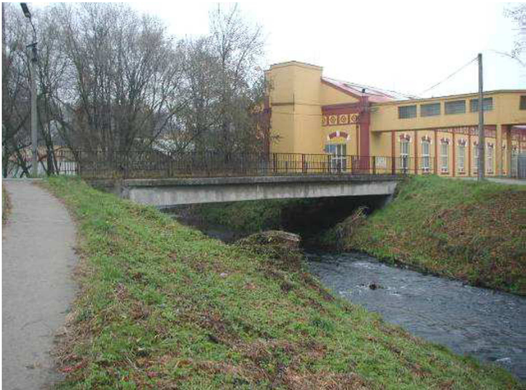
Obr.10 - Betonový most Svitava proti proudu [21]
