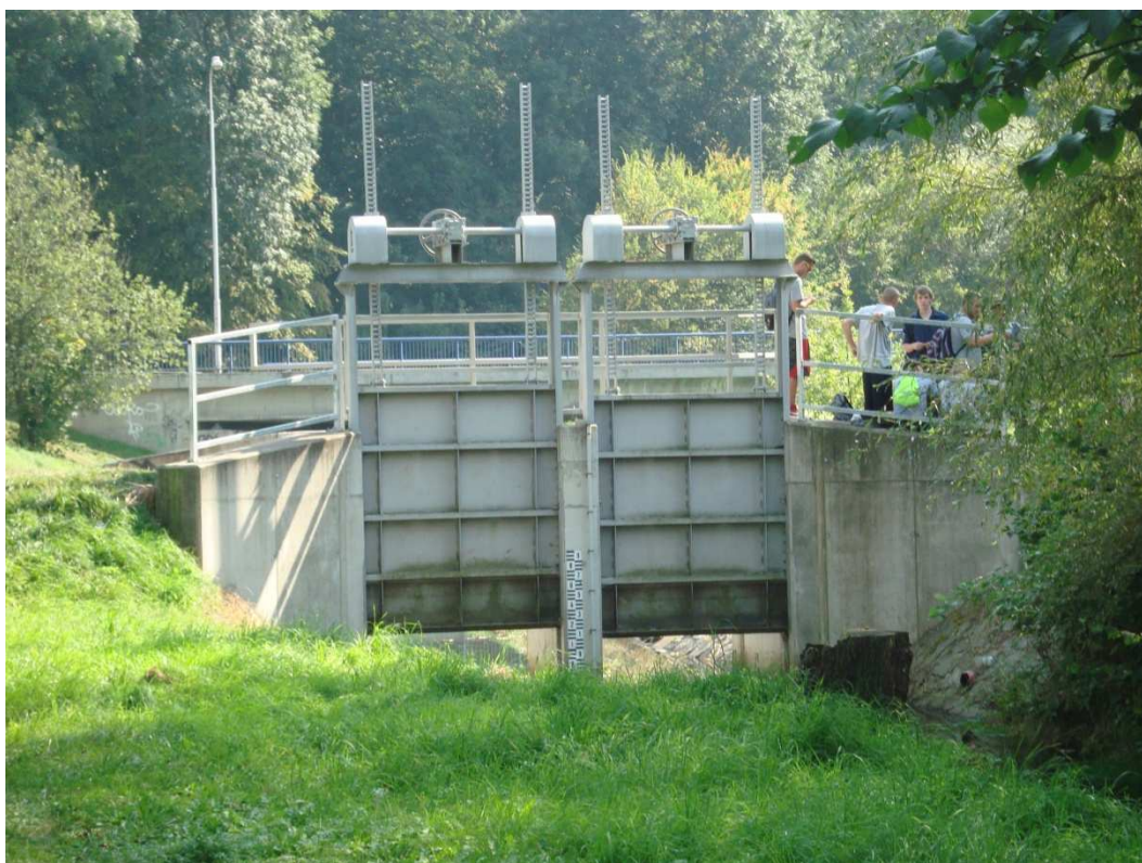
Obr.21 - Stavidlo na výústění náhonu
