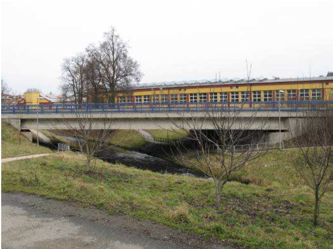
Obr.9 - Silniční most km 60.004 proti toku [21]
