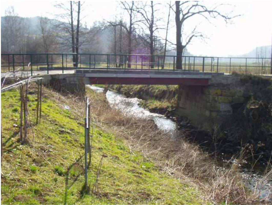
Obr.15 - Silniční mostek Křetínka po proudu[12]
