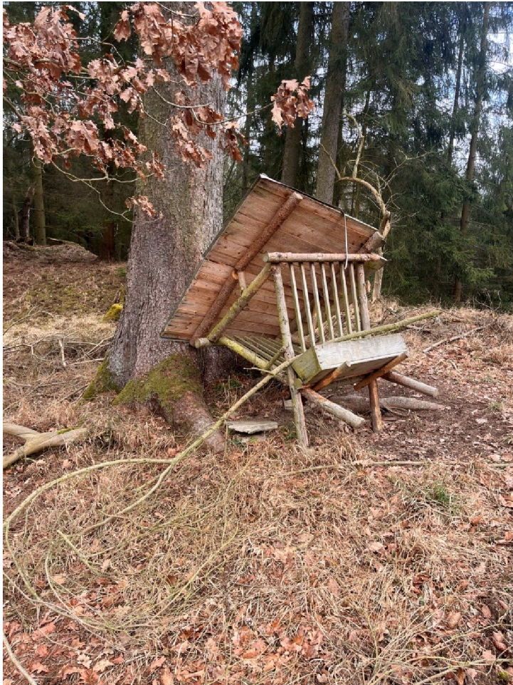
Obrázek 5 - Krmelec 4 poškozený pádem na strom
