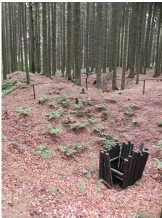
Obr. 6 Šachticový tah u Bílého Kamene s ukázkou historického zapažení šachty.
