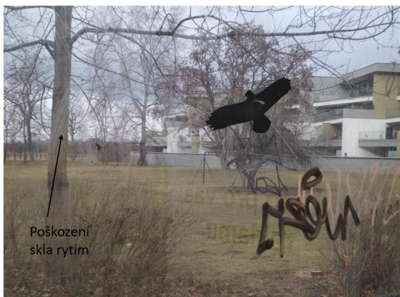
Obr. 26: Poškození zastávky rytím do skleněné plochy a grafity. Ptáci jsou schopni vidět pavučiny pavouků rodu křížák ( Araneus ) na velké vzdálenosti a různé vyryté nápisy do skleněných ploch mohou pavučiny připomínat.
