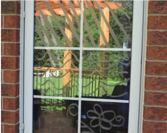
Obr. 20: Improvizované zabezpečení oken kreslením mýdlem na sklo. Zase je nutné dodržet maximálně pěticentimetrovou vzdálenost mezi obrazci. (Převzato z https://flap.org/stop-birds-from-hitting-windows/#solutions dne 5. 3. 2022.)
