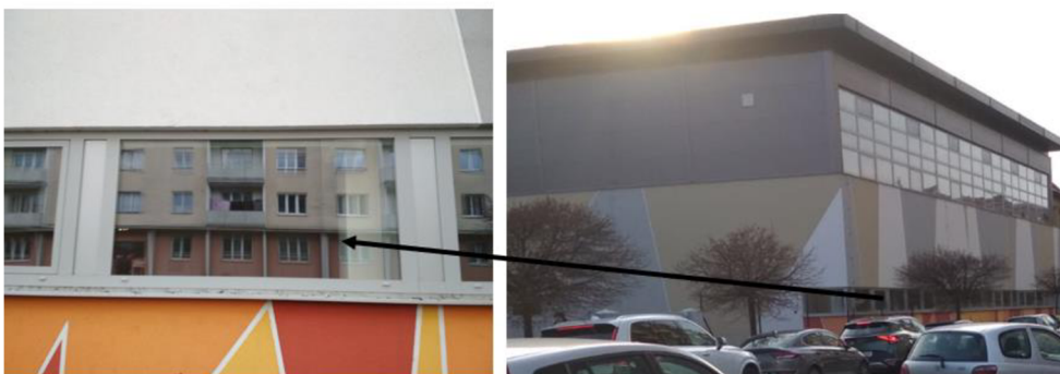
Obr. 10: Velikost skleněné plochy nemusí být zásadním ukazatelem její rizikovosti. Malá řada oken ve výřezu na obrázku vpravo, (celý dům na obrázku vlevo), je pro populaci místních ptáků velkým problémem. Svědčí o tom řada otisků ptáků na těchto oknech.
