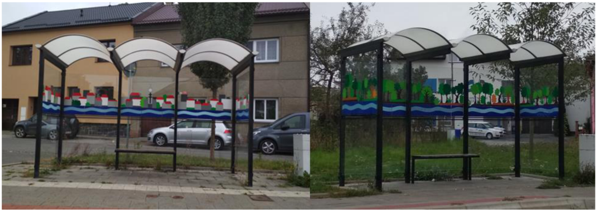
Obr. 27: Polepy na zastávkách č. 46 Frajtovo náměstí (LS) a 47 Frajtovo náměstí (PS). Výrazně eliminují plochu skla, i když nejsou dostatečným zabezpečením proti střetům ptáků s těmito zastávkami.
