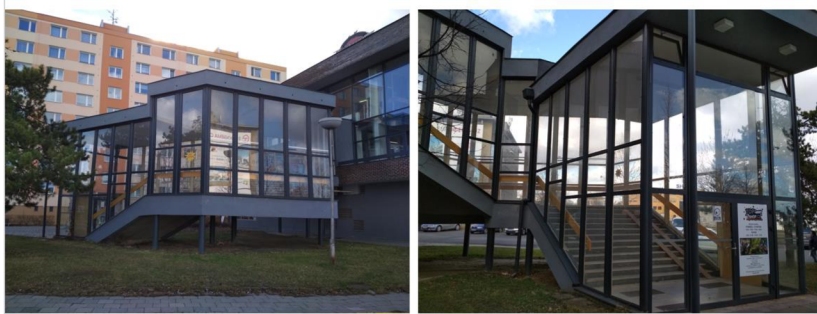
Obr. 34: Skleněné schodiště na ulici Velkomoravská.
