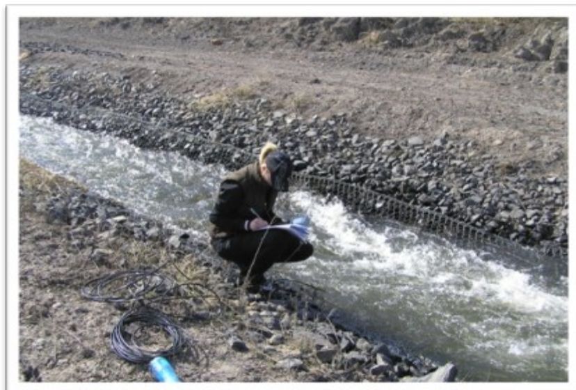
Foto č. 55: Měření na konci přívodního kanálu MM 2(25. 3. 2010)
