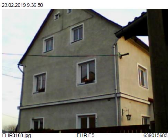
Obrázek 26 Termovizní měření budovy bez zateplení (Zdroj: vlastní)
