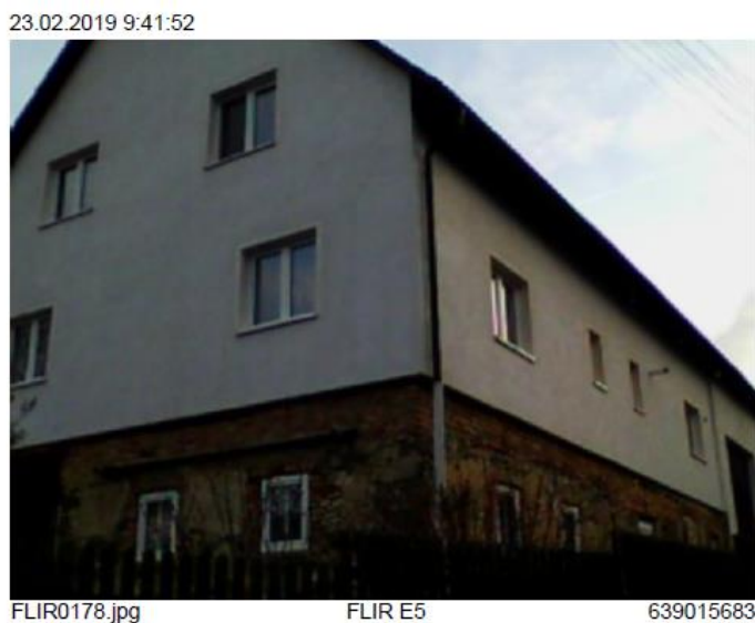
Obrázek 27 Termovizní měření dodatečně zateplené budovy (Zdroj: vlastní)
