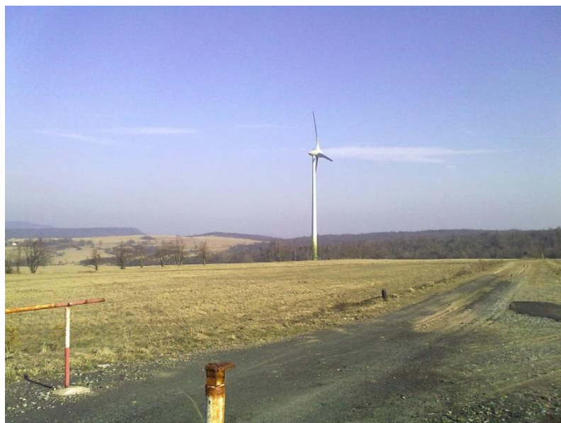
Obrázek 50 Větrná elektrárna ENERCON E-70 E4 v lokalitě Petrovice (Zdroj: vlastní fotografie)
