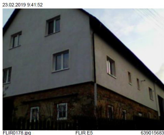
Obrázek 27 Termovizní měření dodatečně zateplené budovy (Zdroj: vlastní)
