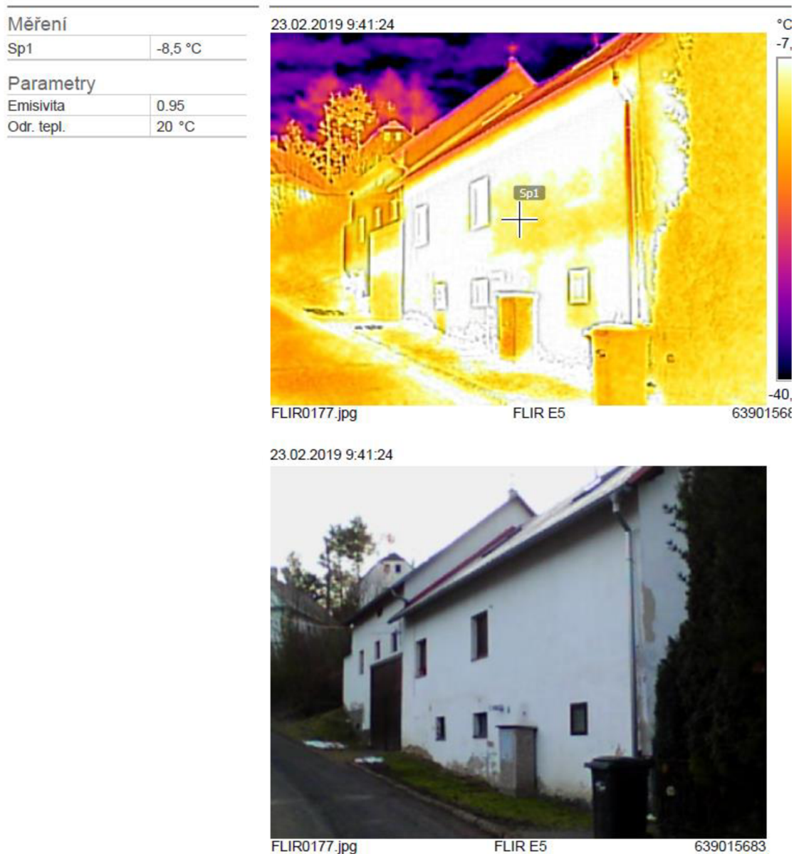
Obrázek 28 Termovizní měření nezateplené budovy (Zdroj: vlastní)
