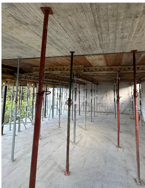
Obrázek 71: Postup při částečném odbedňování stropní k-ce (autor)
