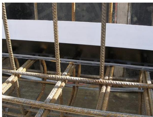
Obrázek 64: Montáž těsnícího plechu (28)
