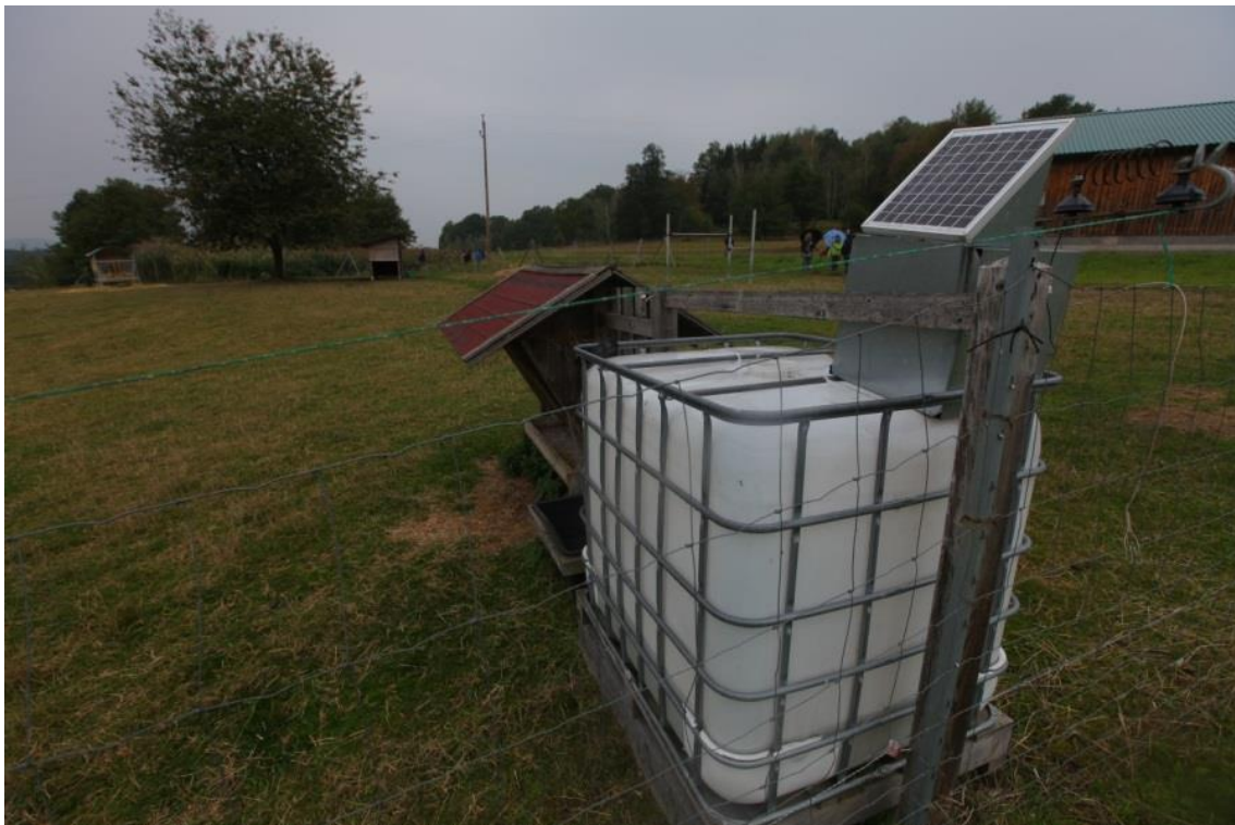
Obr. 30 Nádrž na srážedlo a solární panel na pohon čerpadla příklad z Rakouska (archiv ÚVHK)
