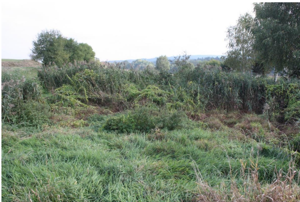
Obr. 13: Kořenová čistírna odpadních vod Chmelná; (foto: Havlíčková; 2016).
