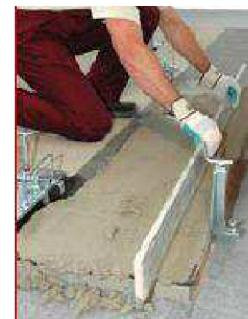
Po té co máme vodorovnou vrstvu zakládací malty hotovou, začínáme v rozích osazením rohových cihel. Každá rohová cihla je oproti rohovým cihlám v sousedních vrstvách půdorysně otočená o 90°. Tyto cihly se spojí zednickou šňůrou vedenou z vnější strany zdíva. Do čerstvé malty se pokládá cihla po cihle podél šňůry těsně vedle sebe, tak aby se vzájemně dotýkaly. Plocha cihel se koriguje podle vodováhy pomocí gumové paličky.
