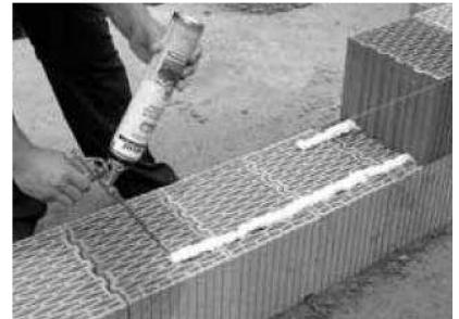
V případě přerušení zdění uzavřeme aplikační pistoly stavěcím šroubem, po následném lehkém mechanickém očištění ústí aplikační pistole můžeme pokračovat v práci.
