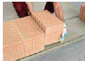
Je zapotřebí dbát stále na správnou konzistenci malty. Osazované cihly by mělo být možné pohodlně vyrovnat, nesmí se přitom příliš vtlačovat do malty. V případě, že je již malta příliš tuhá, lze na ni nanést vrstvu malty pro tenké spáry. Při osazování první vrstvy je velmi důležité, aby výškové rozdíly mezi jednotlivými cihlami nepřesahovali 1 mm, z důvodu dalšího vyzdívání na tenkou vrstvu malty o tloušťce 1 mm.
