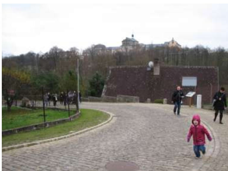
Obrázek 22 - Dokončené práce na komunikacích
