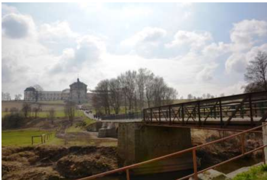
Obrázek 15 - Část mostu k rekonstrukci
