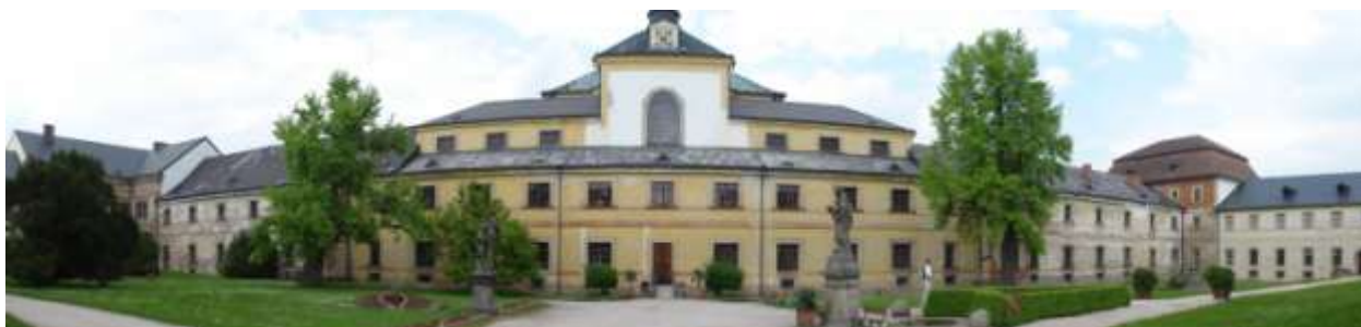
Obrázek 11 - Nádvoří hospitalu před rekonstrukcí
