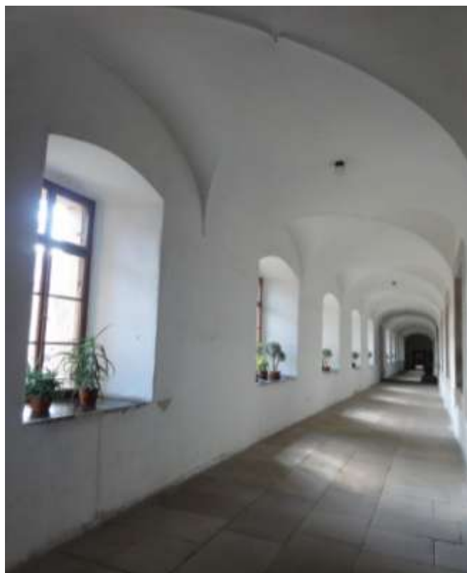
Obrázek 18 - Chodba před restaurováním
