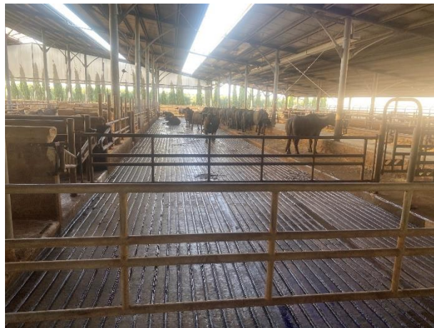
Obr. 20. Podlaha s automatickým odklizením
