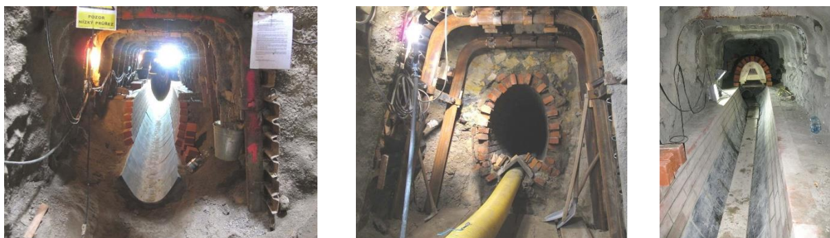
Obrázek 14: Vlevo - výstavba definitivní konstrukce stoky; uprostřed - zajištěné rozvolněné bloky za ostěním stoky; vpravo - uložení bubnu a vyzdění zbývající části stoky [7]
