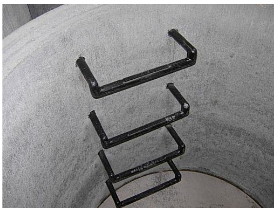
Obrázek 23: Skruž se zabudovanými poplastovanými stupačkami [10]
