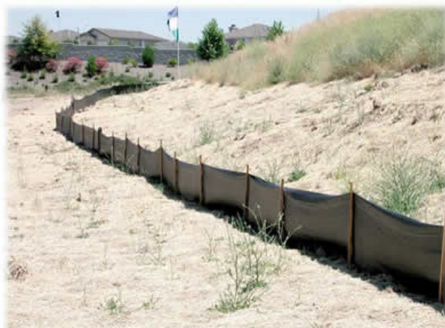
Obrázek č. 20 Ochrana proti erozi zeminy
