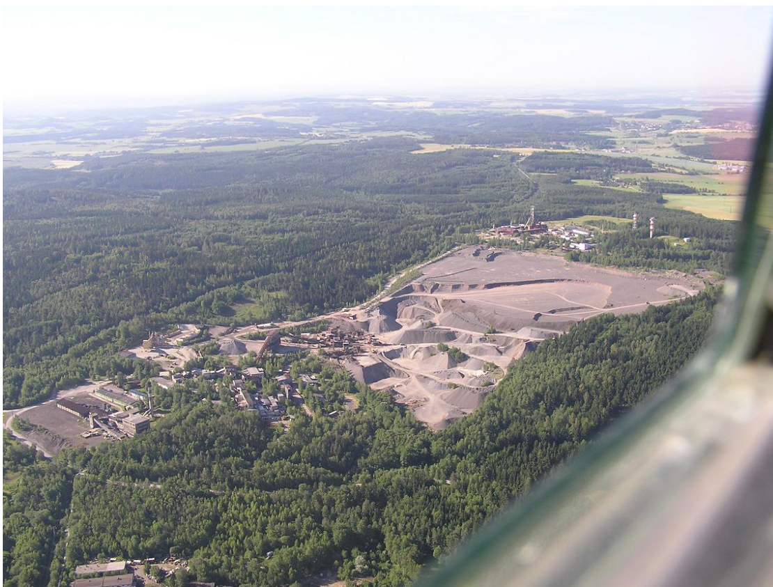
Obr. č. 6 Letecký snímek – bývalá úpravná I. máje, dnes areál drtící stanice ECOINVEST v oblasti Příbram - Bytíz. . Foto Ing. Škvor, DIAMO, s. p.
