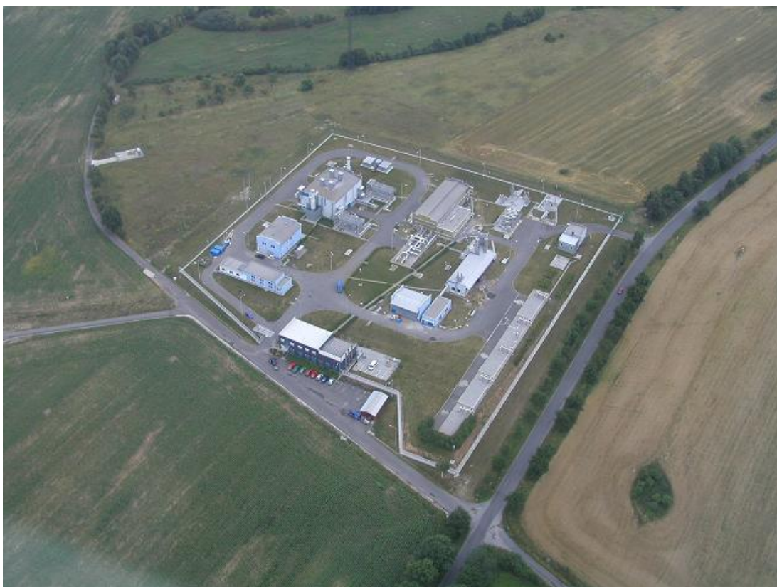
Obr. č. 4 Letecký snímek podzemního zásobníku plynu, raženého na 21. patře v hloubce 1000 m jámy č. 16. Foto Ing. Škvor, DIAMO, s. p.
