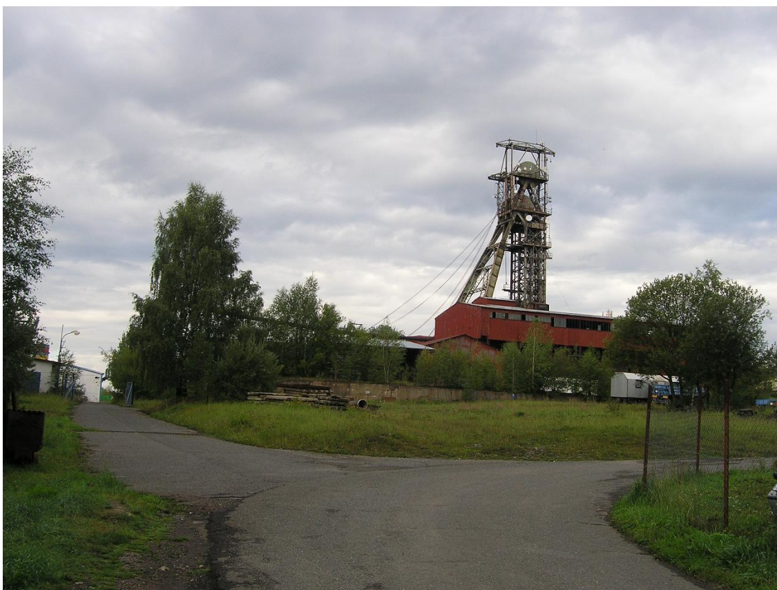
Obr. č. 10 Šachta č. 16 - Příbram Háje. Foto Ing. Škvor, DIAMO, s. p.
