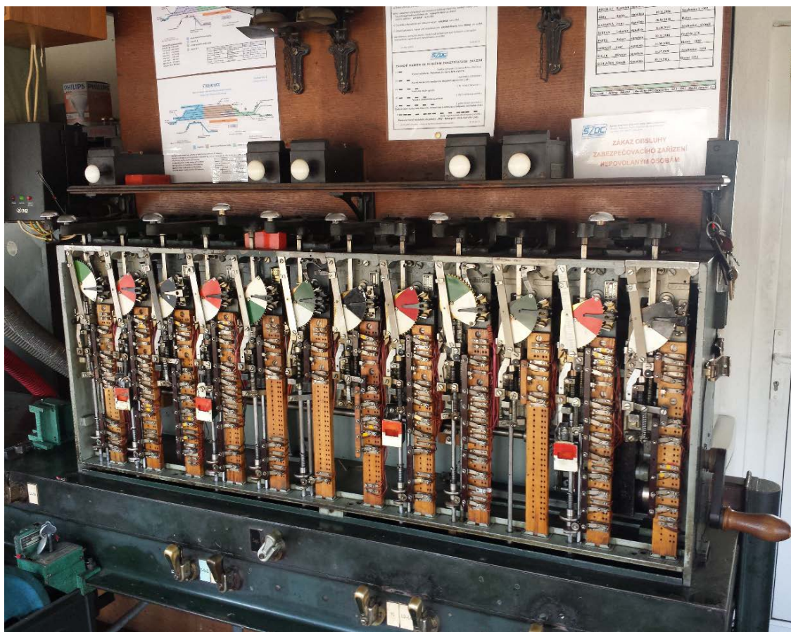
Obrázek 12: Vložky elektromechanického přístroje – Strakonice St.2 (autor: Jan Bárta)
