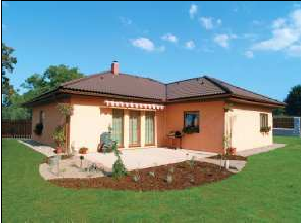
Obr.15: Čelní pohled na RD1 (Žerůtky)
