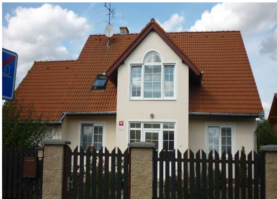
Obr.20: Čelní pohled na RD6 (Přímětice)
