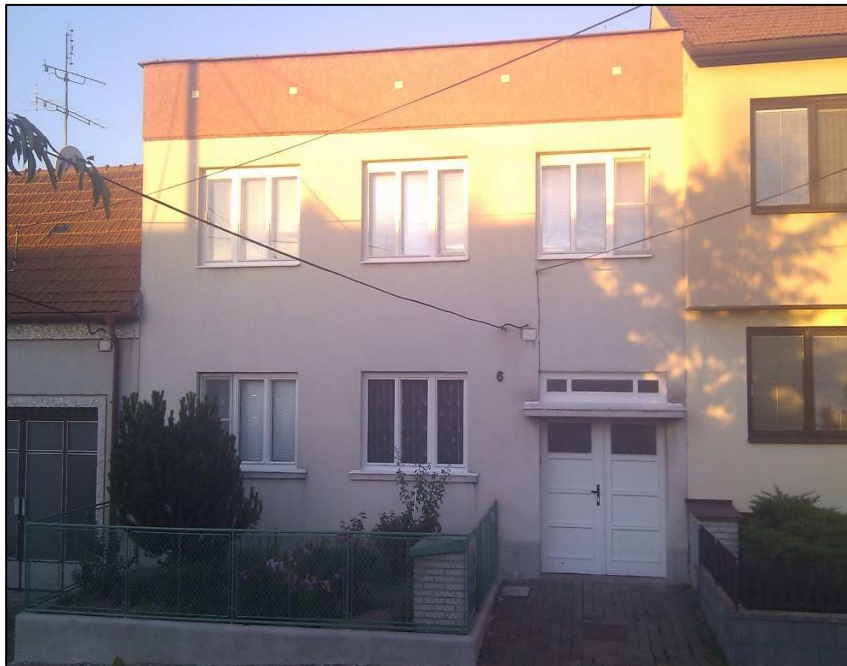
Obr.21: Čelní pohled na RD7 (Znojmo-Mramotice)
