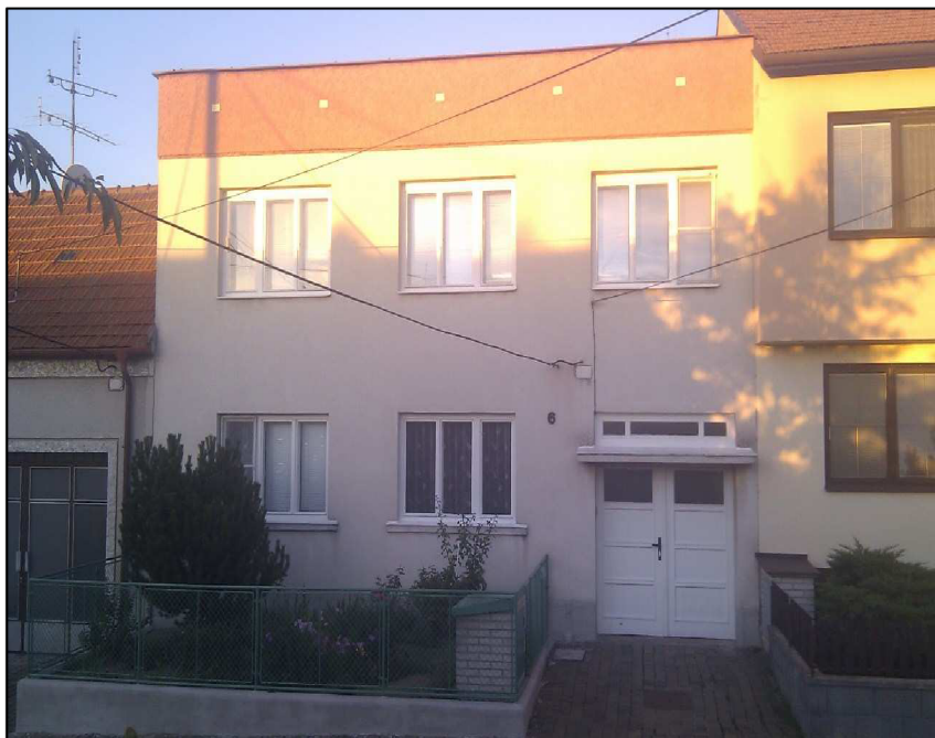
Obr.21: Čelní pohled na RD7 (Znojmo-Mramotice)
