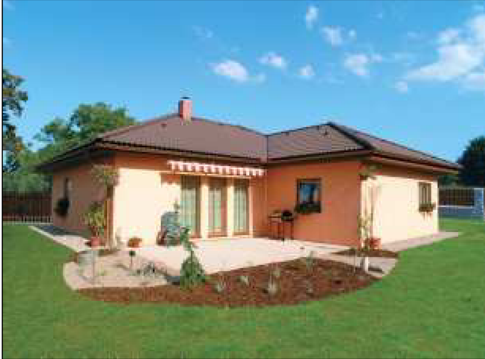
Obr.15: Čelní pohled na RD1 (Žerůtky)
