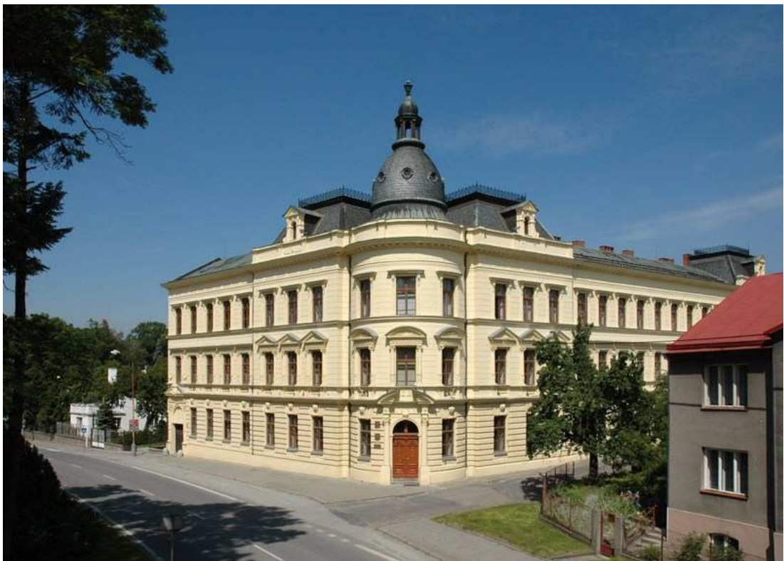
Obrázek č. 3 Střední průmyslová škola stavební
