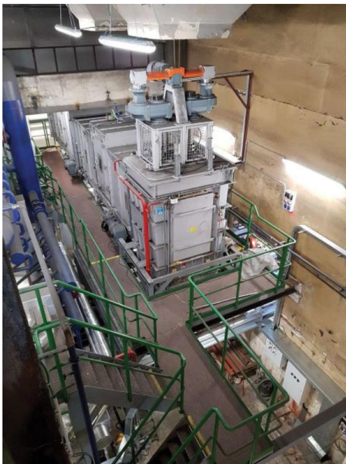
Obrázek 16 – Kotel K6 na biomasu – Jindřichův Hradec
