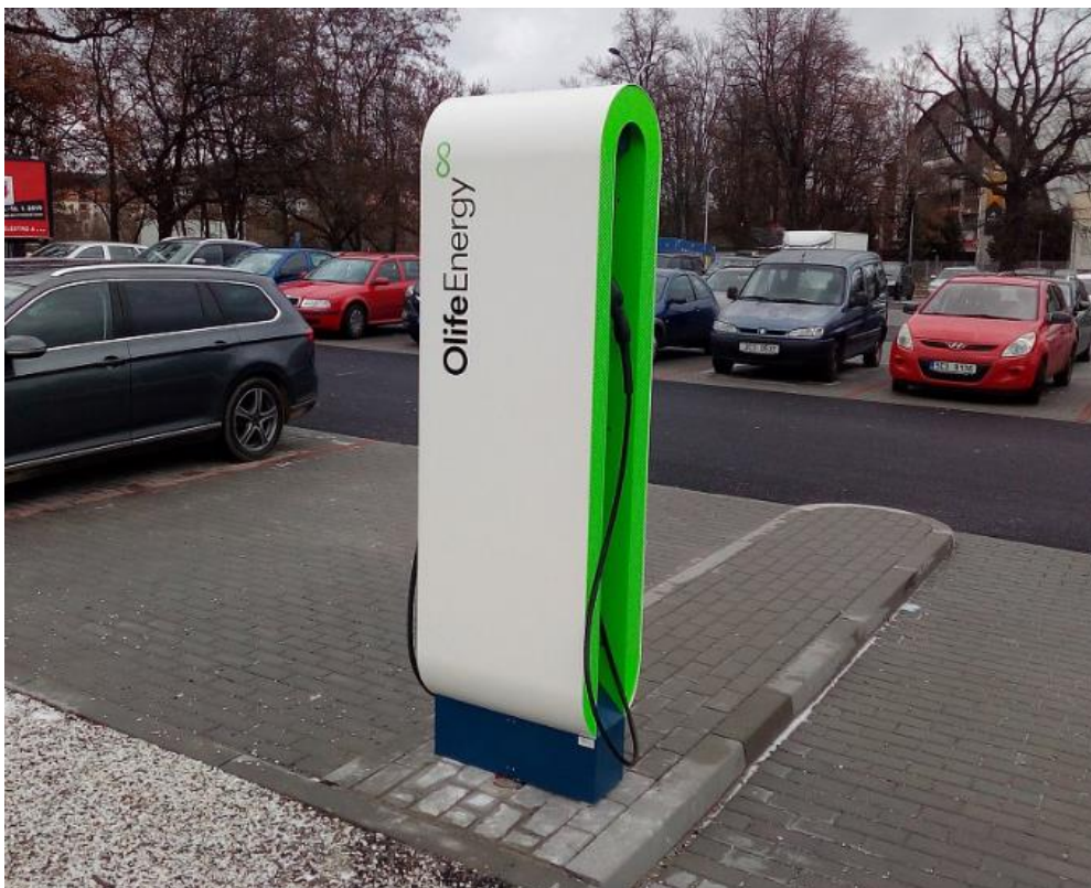
Obrázek 18 – Dobíjecí stanice pro elektromobily
