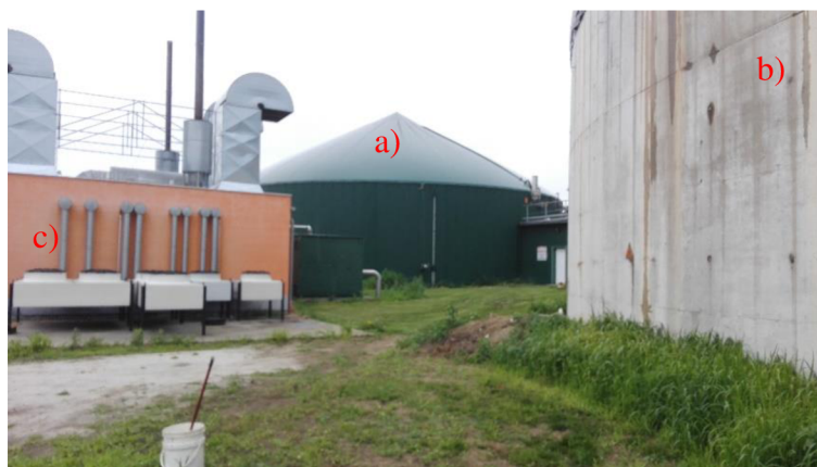
Obrázek 10 bioplynové stanice zemědělského družstva Sever Loukovec (středisko Chocnějovice) a) jedna z fermentačních nádrží, b) skladovací jímka, c) kogenerační jednotka
