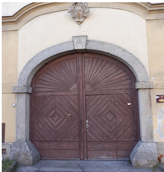
95. Stará Říše, portál fary (1758), katalog. č. 53 – celkový pohled.
