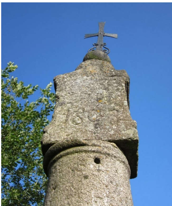
113. Zvolenovice, boží muka (1803), katalog. č. 65 – stav v roce 2013, zadní strana kaplice.
