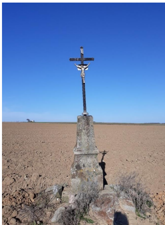
33. Knínice, kříž (1860), katalog. č. 18 – celkový pohled, stav v roce 2019.
