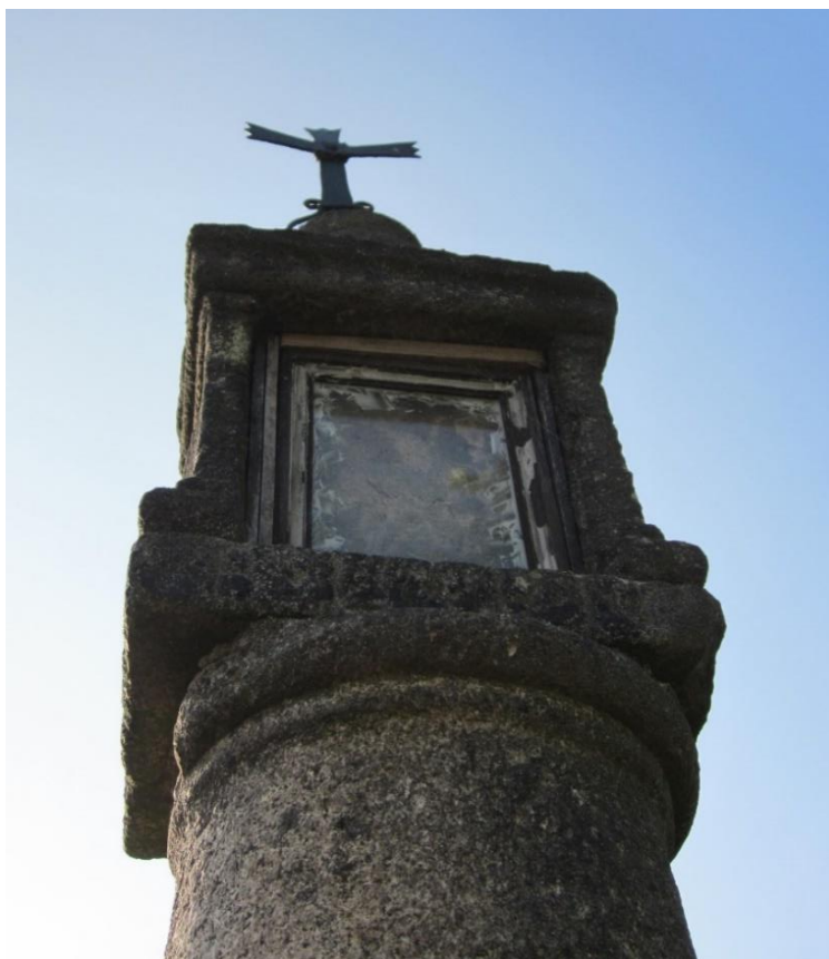
112. Zvolenovice, boží muka (1803), katalog. č. 65 – stav v roce 2013, přední část kaplice.
