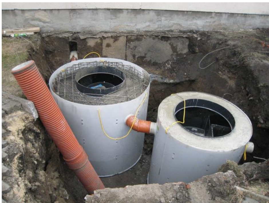
Obr. 3: Lapák tuků a olejů [3]
