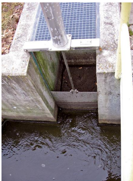
Obr. 2: Rozdělovací objekt ČOV Kolín[2]
