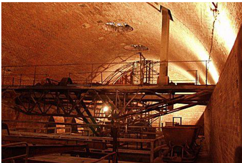
Obr. 1: Lindleyho čistírna odpadních vod v Praze [1]
