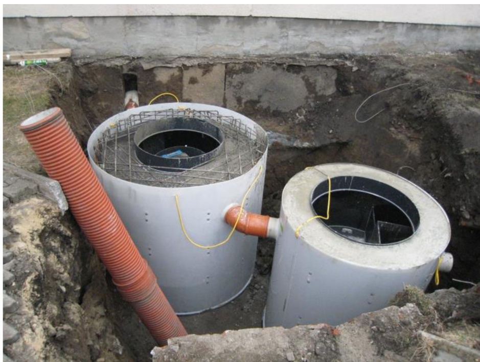
Obr. 3: Lapák tuků a olejů [3]
