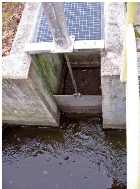
Obr. 2: Rozdělovací objekt ČOV Kolín[2]
